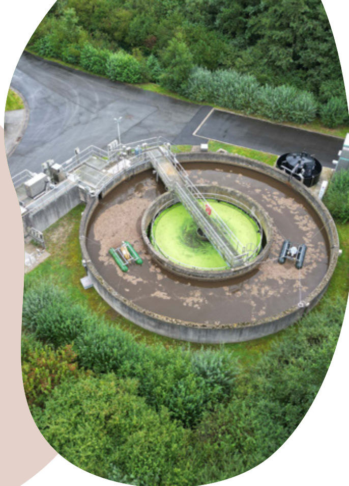
De waterzuiveringsinstallatie van Baliebrugge zuivert het afvalwater van ongeveer 1.600 inwoners en loost op de Velddambeek
