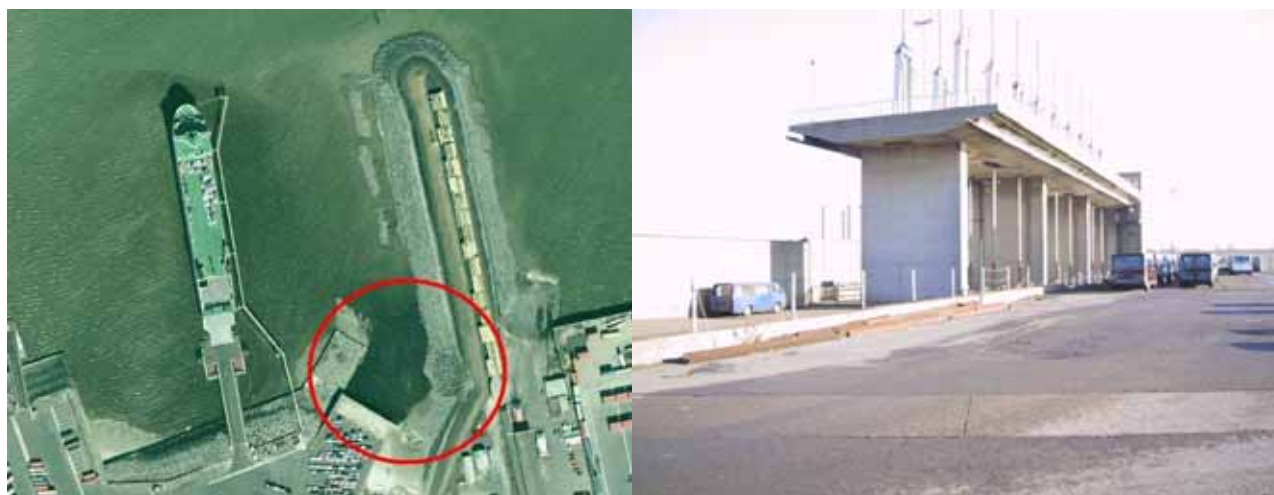
Uitwatering Leopoldkanaal-Afleidingskanaal te Heist
