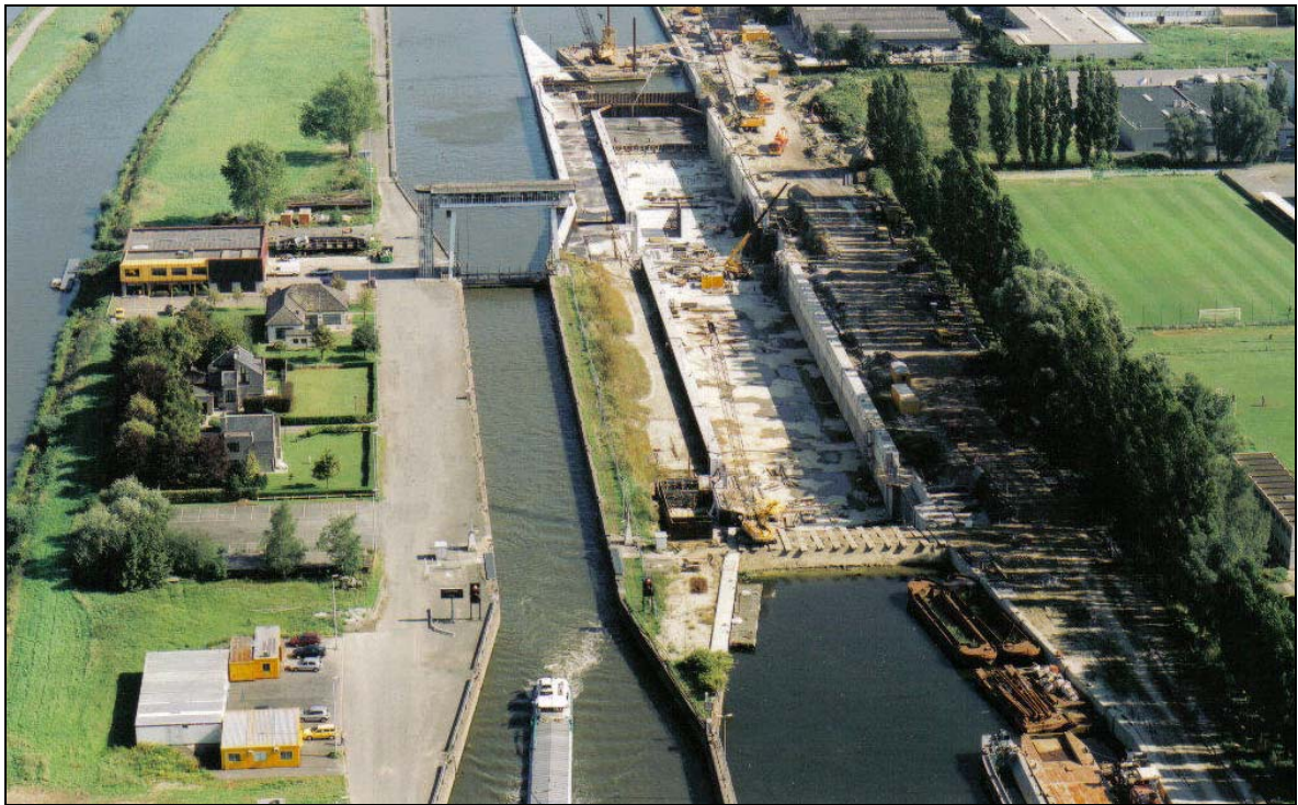
Figuur 2: Nieuwe Sluis te Evergem, nog in aanbouw (W&Z)
