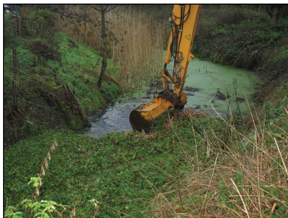
Figuur 6: machinale ruiming van waternavel met kraan
