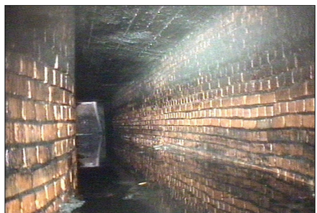
Figuur 3: Camera-inspectie van de Oost-Eeklose beek onder de Ertveldsesteenweg
