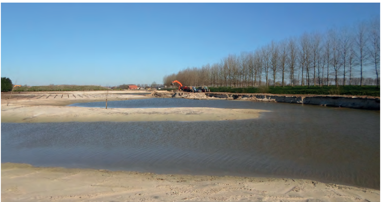
De werken lopen van de stuw aan de Gemenestraat tot aan de Schoorhavenweg. Foto van tijdens de werken.
