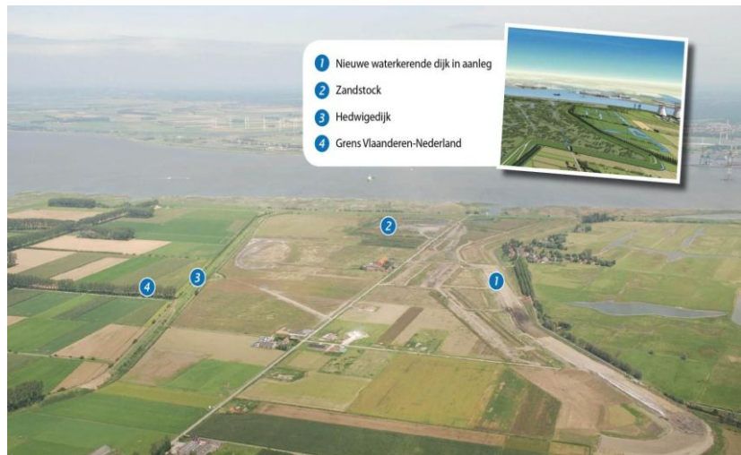
Figuur 3: Tweede fase van de ringdijk in aanleg
