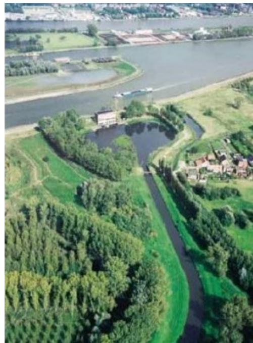
Wachtboezem met pompgemaal in de huidige situatie
