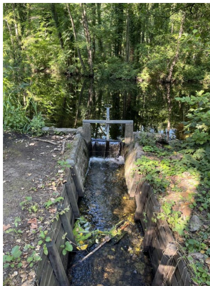
Overloopconstructie van Wijnegemhof naar het Groot Schijn
