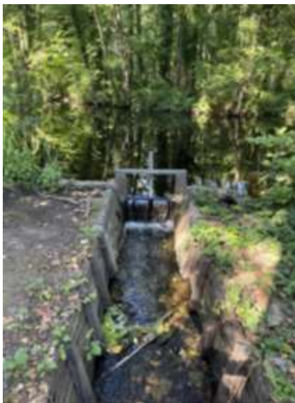
Overloopconstructie van Wijnegemhof naar het Groot Schijn
