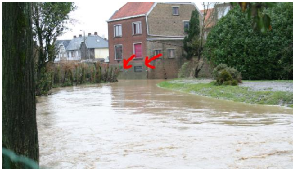
Figuur 19: Café The Bridge met aanduiding kelderramen
