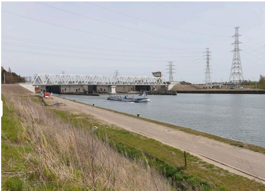
Pompinstallatie Albertkanaal in Genk
