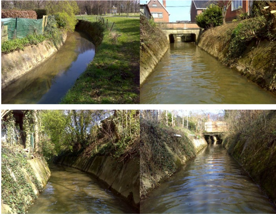
Algemeen beeld van de gebetonnerde bedding van de Begijnebeek tussen de Tulpenstraat en de Omer Vanaudenhovenlaan
