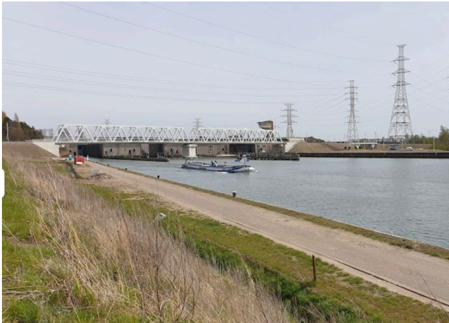
Pompinstallatie Albertkanaal in Genk
