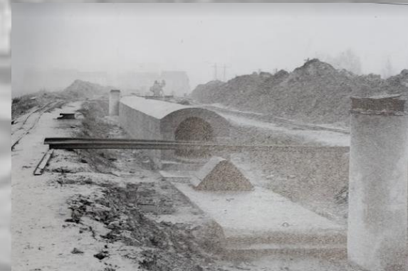
Aanleg collector Sint-Lambrechts-Woluwe
