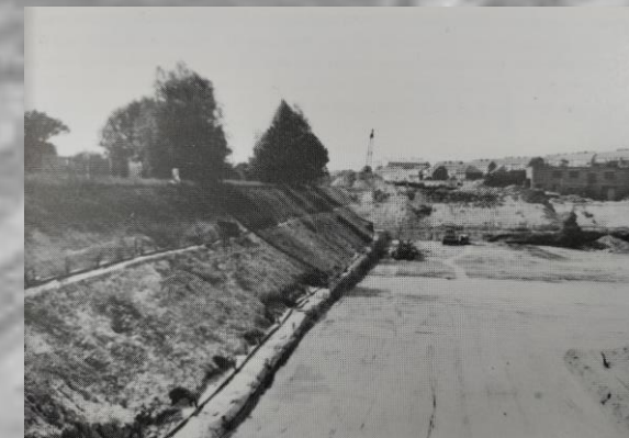
Aanleg spaarkom Diegem
