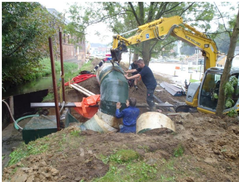
Foto: plaatsing hevelvistrap langs de IJse in Overijse (© Mieke De Wilde)
