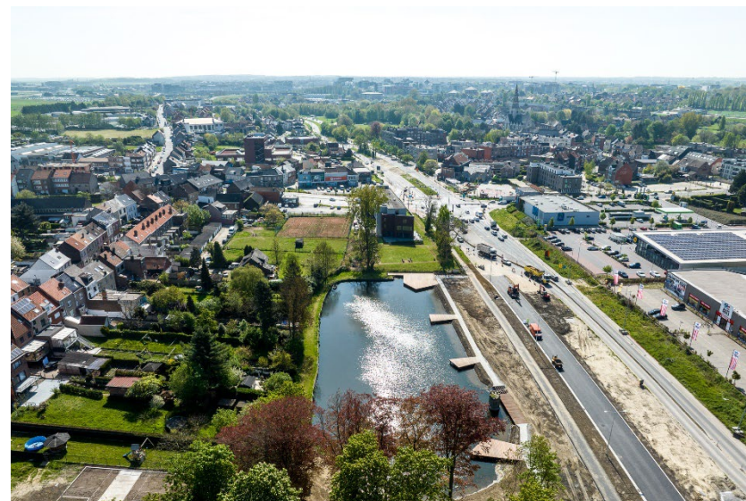
Aanleg buurtpark aan de Donjonvijvers in Machelen
