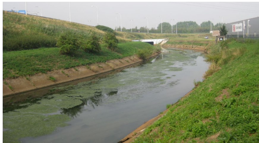
Verstevigde oevers van de Vrouwvliet in Mechelen (© VMM)
