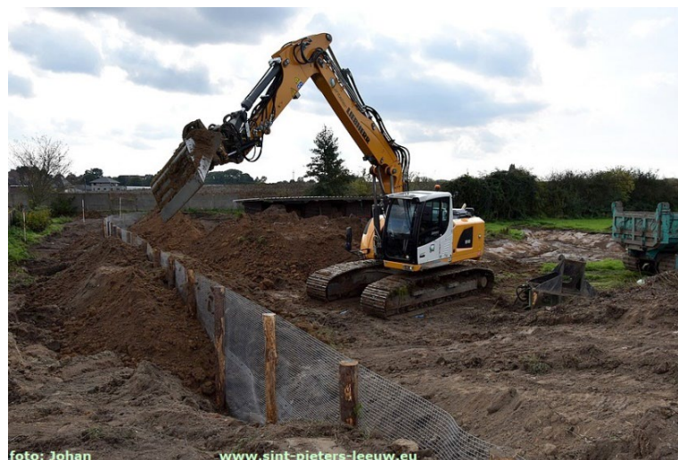
Aanleg erosiepoel in de Bezemstraat in Sint-Pieters-Leeuw (© sint-pieters-leeuw.eu)
