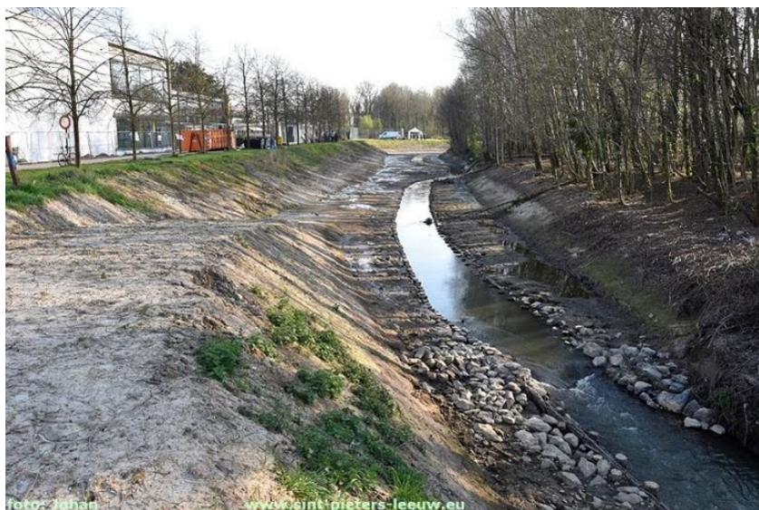
Aanleg van een zomer- en winterbed op de Zuunbeek ter hoogte van het Wildersportcomplex (© www.sint-pieters-leeuw.eu )
