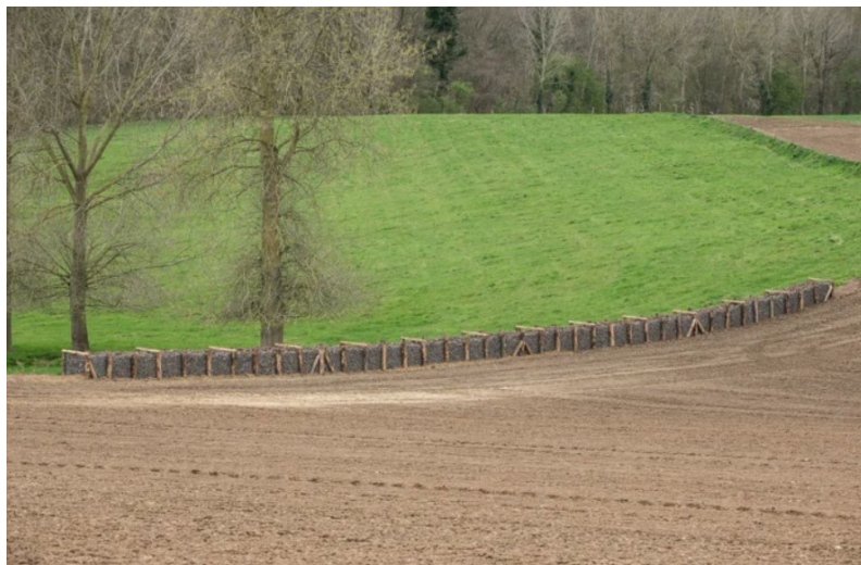
Houthakseldam langs de Zavelstraat in Huldenberg (© provincie Vlaams-Brabant)
