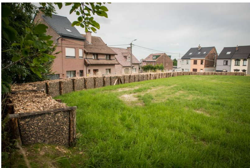
Houthakseldam ter hoogte van de Kasteelbrakelsesteenweg in Halle (© provincie Vlaams-Brabant)
