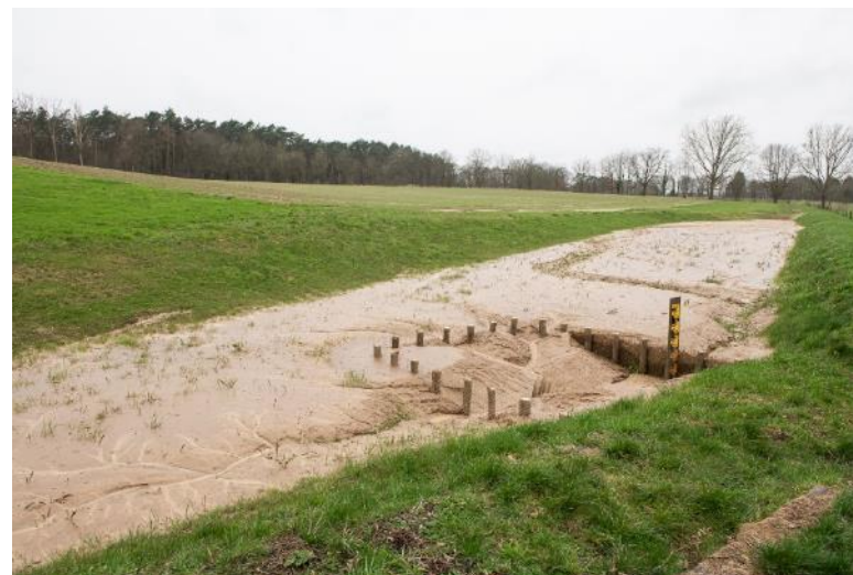
Erosiepoel aan de Kwadebeek in Sint-Genesius-Rode (© provincie Vlaams-Brabant)
