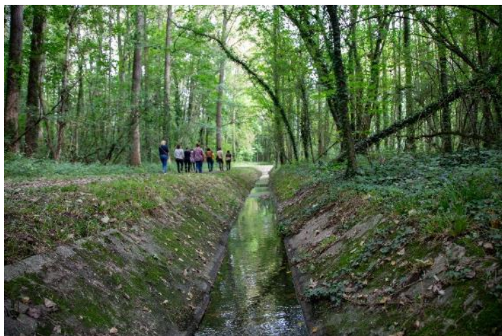
Rechtgetrokken en verstevigde Kautesteenbeek (© VMM)
