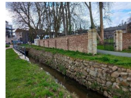
De kasteelmuur met overwelfde IJse voor de werken, en de herstelde muur met open IJse na de werken (© VLM)
