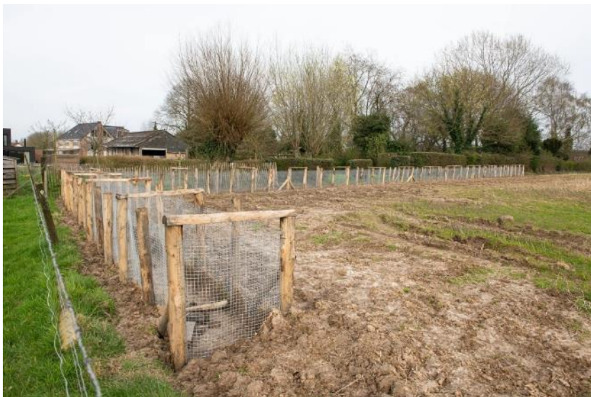
Plaatsing van de houthakseldam aan de Frans Luckxstraat in Lennik (© provincie Vlaams-Brabant)
