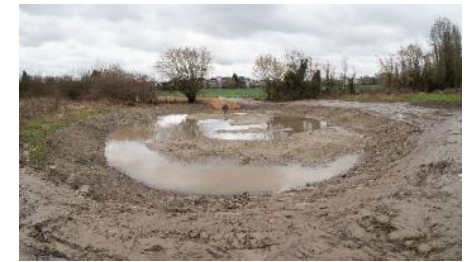
Erosiepoel en wadi in de Jean Monnetwijk in Zaventem (© Provincie Vlaams-Brabant)
