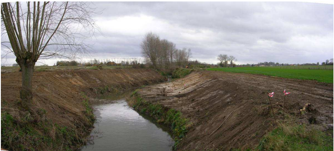
Poperingevaart stroomafwaarts Oostlaan – zachtere taludhelling
