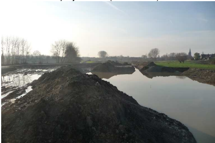
Werken aan de uitbreiding van het bufferbekken (december 2009)
