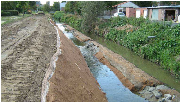
Poperingevaart in stadspark Poperinge – aangelegde vispassage
