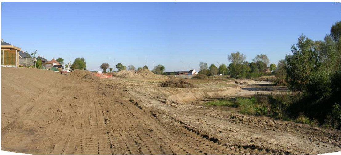
Poperingevaart stroomafwaarts stadspark Poperinge – zachtere taludhelling
