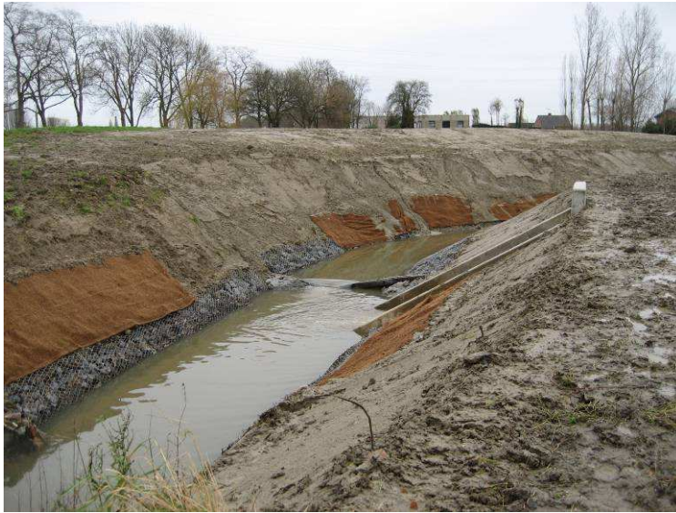
Inrichting van een deel van de Ieperlee met schanskorven en kokosmatten.
