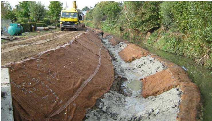
Poperingevaart in stadspark Poperinge – aanleg vispassage
