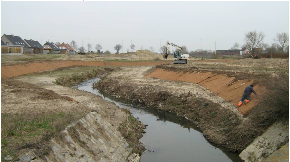
Poperingevaart stroomafwaarts stadspark Poperinge – zachtere taludhelling – aanleg kokosmat (foto VMM AOW – Karin Vermeulen)
