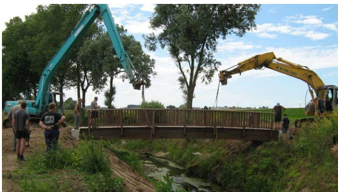
Poperingevaart stroomafwaarts Poperinge – aanleg voetgangersbrug (foto VMM AOW – Karin Vermeulen)
