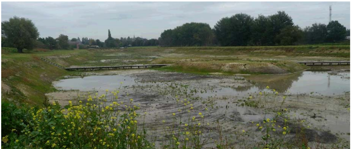
Afgewerkte uitbreiding bufferbekken in Kortemark langs de Spanjaarbeek (foto dienst waterlopen provincie West-Vlaanderen)
