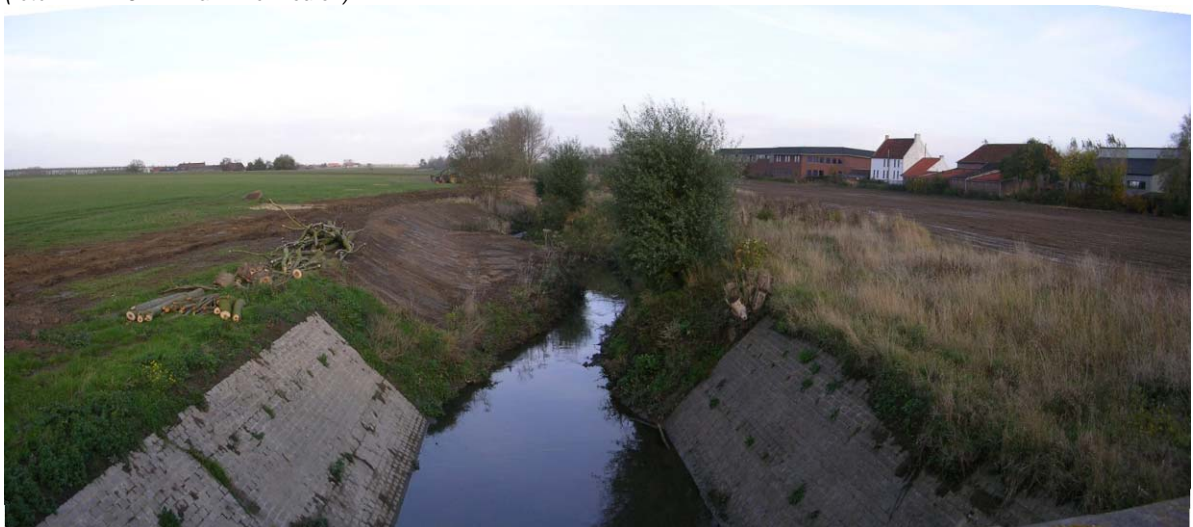
Poperingevaart stroomafwaarts Poperinge – aanleg oeeververflauwing (foto VMM AOW – Karin Vermeulen)
