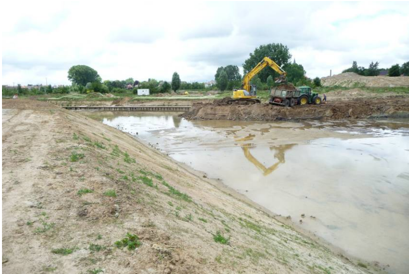
Werken aan de uitbreiding van het bufferbekken – 2010 (foto dienst waterlopen provincie West-Vlaanderen)
