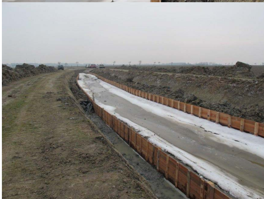
Oeverversterkingen aan het Graningate te Middelkerke (foto dienst waterlopen provincie West-Vlaanderen)
