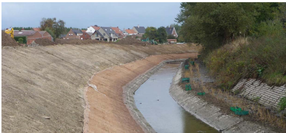
Spanjaardbeek tijdens uitvoering d.d. 13 oktober 2009 (foto dienst waterlopen provincie West-Vlaanderen)
