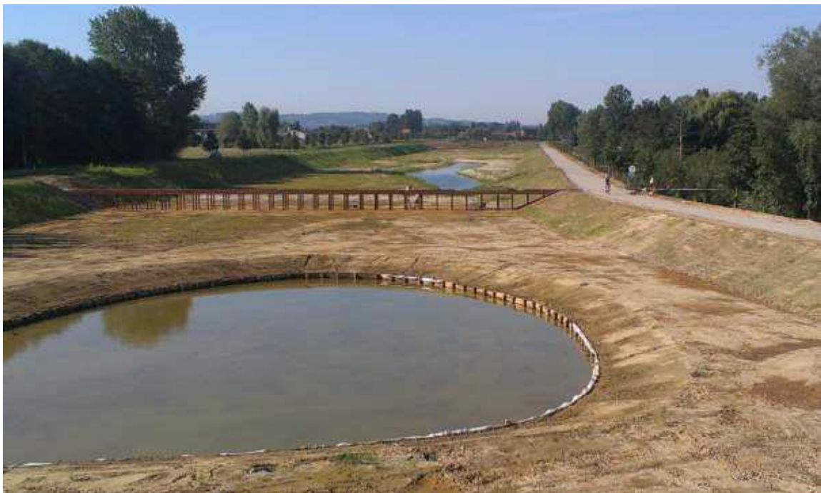
Figuur 1. Actie 1.5 uit het deelbekkenbeheerplan Hoppeland: Uitvoering van het bufferbekken op de Vleterbeek d.d. september 2013
