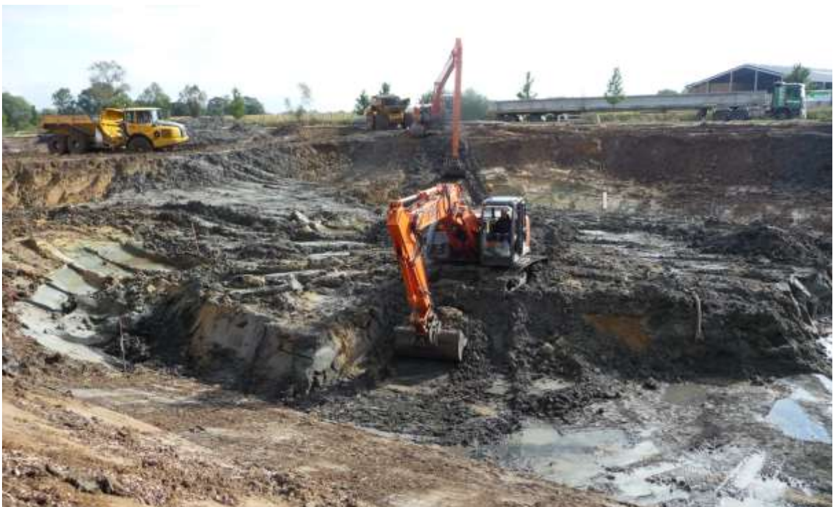
Grondwerken gecontroleerd overstromingsgebied d.d. september 2012.
