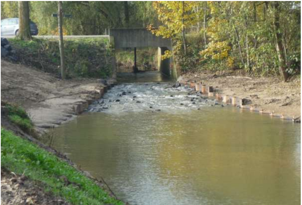
Aanleg vispassage Vleterbeek d.d. november 2012.
