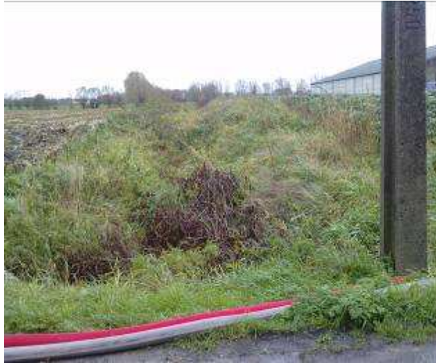
Figuur 11: niet onderhouden private afvoergracht naar de Bankbeek te Wevelgem (Daalstraat)
