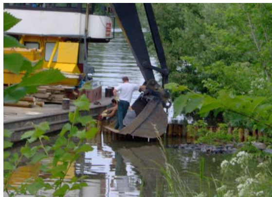
Figuur 4: plaatsen nieuwe oeververdediging op de RO van de Leie thv Olsene (juni 2008)
