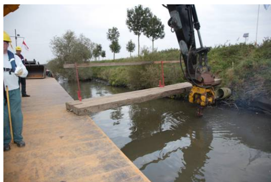
Figuur 3: heien eerste paal op de grens Menen/Wevelgem (oktober 2008)
