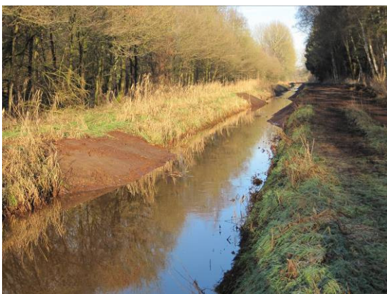
Fig. 6: Linksboven: De Oude Lossing in Kinrooi voor de ruimingswerken Boven: De Oude Lossing na de ruimingswerken Links: Door een aanvulling van de bedding kan de Lossing (Emissaire) in Kinrooi weer kronkelen.
