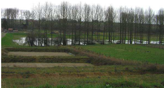
Foto 2: Aanleg overstromingsgebied in vallei van de Jeker stroomopwaarts van Lauw, met bezinkingsbekkens (links) en zandvang (rechts).
