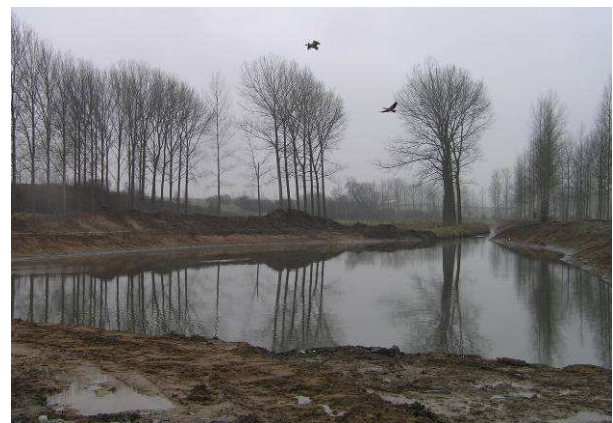
Foto 2: Aanleg overstromingsgebied in vallei van de Jeker stroomopwaarts van Lauw, met bezinkingsbekkens (links) en zandvang (rechts).
