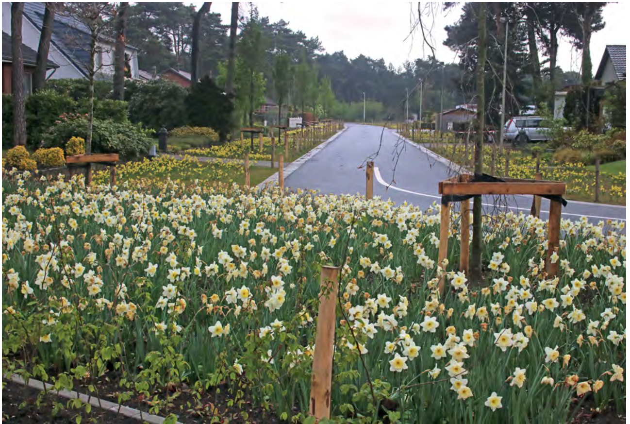
In 2016 werden de stoepen in de Zavelstraat in Pelt vervangen door groene bermen met infiltratiekommen. Als het regent, loopt het water van de straat naar de groene bermen, waar het kan infiltreren in de bodem (Foto: gemeente Pelt).
