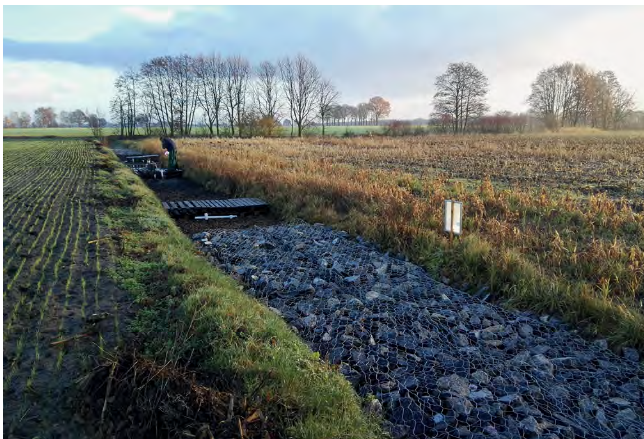
Aanleg van een bioreactor in een gracht naar de Bolissenbeek (Foto: Proefcentrum Fruiteelt vzw).
