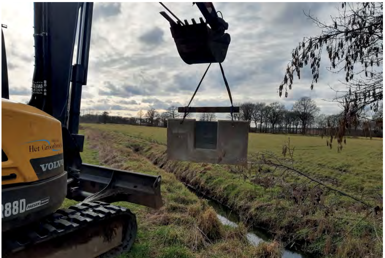
Een regelbaar stuwte wordt in de perceelsgracht geplaatst (Foto: watering Het Grootbroek).
