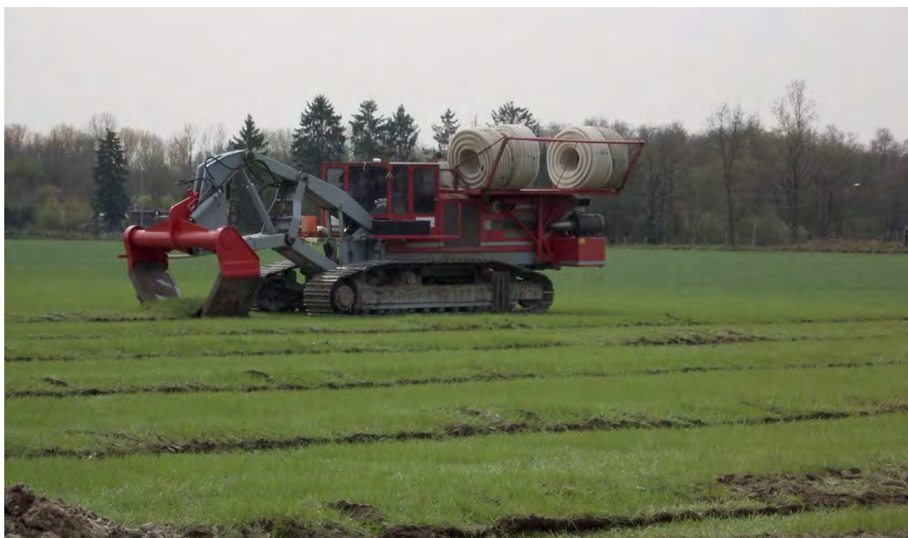
Machine legt drainagebuizen voor peilgestuurde drainage
