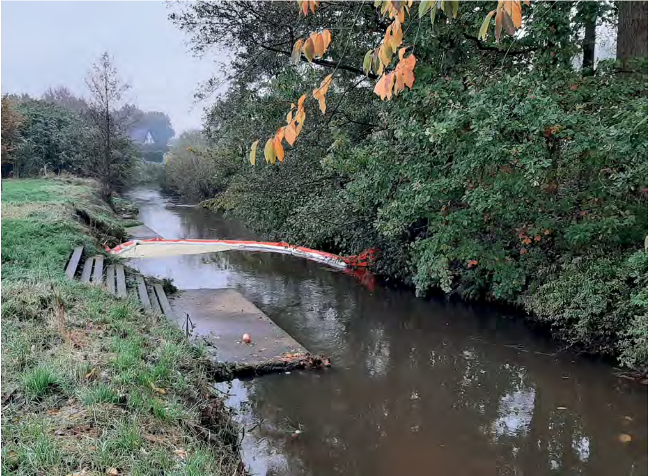
Een olie-absorberende slang: eerste hulp bij olieverontreiniging..
