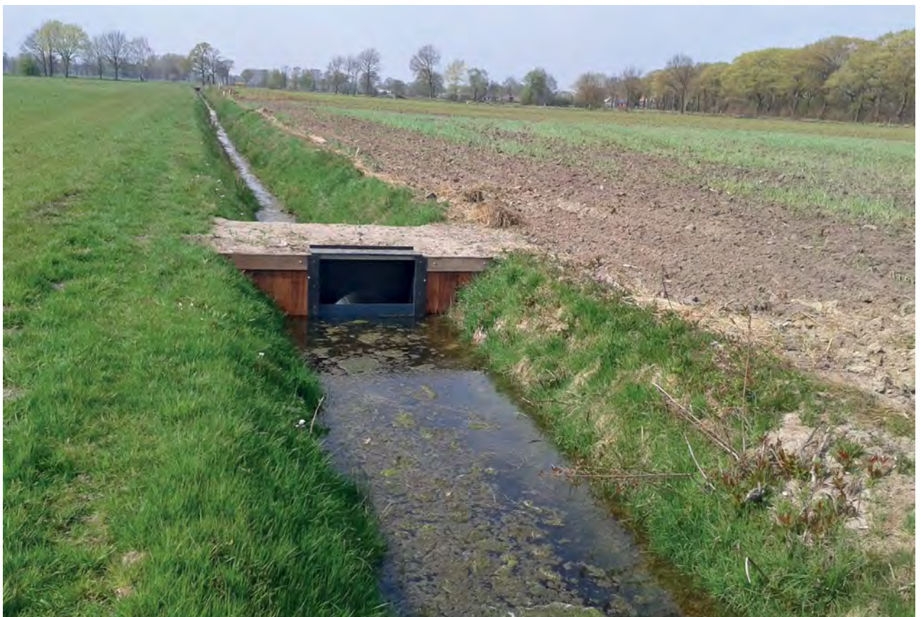
Een regelbaar stuwteje op een perceelsgracht (Foto: Boerenatuur Vlaanderen).
