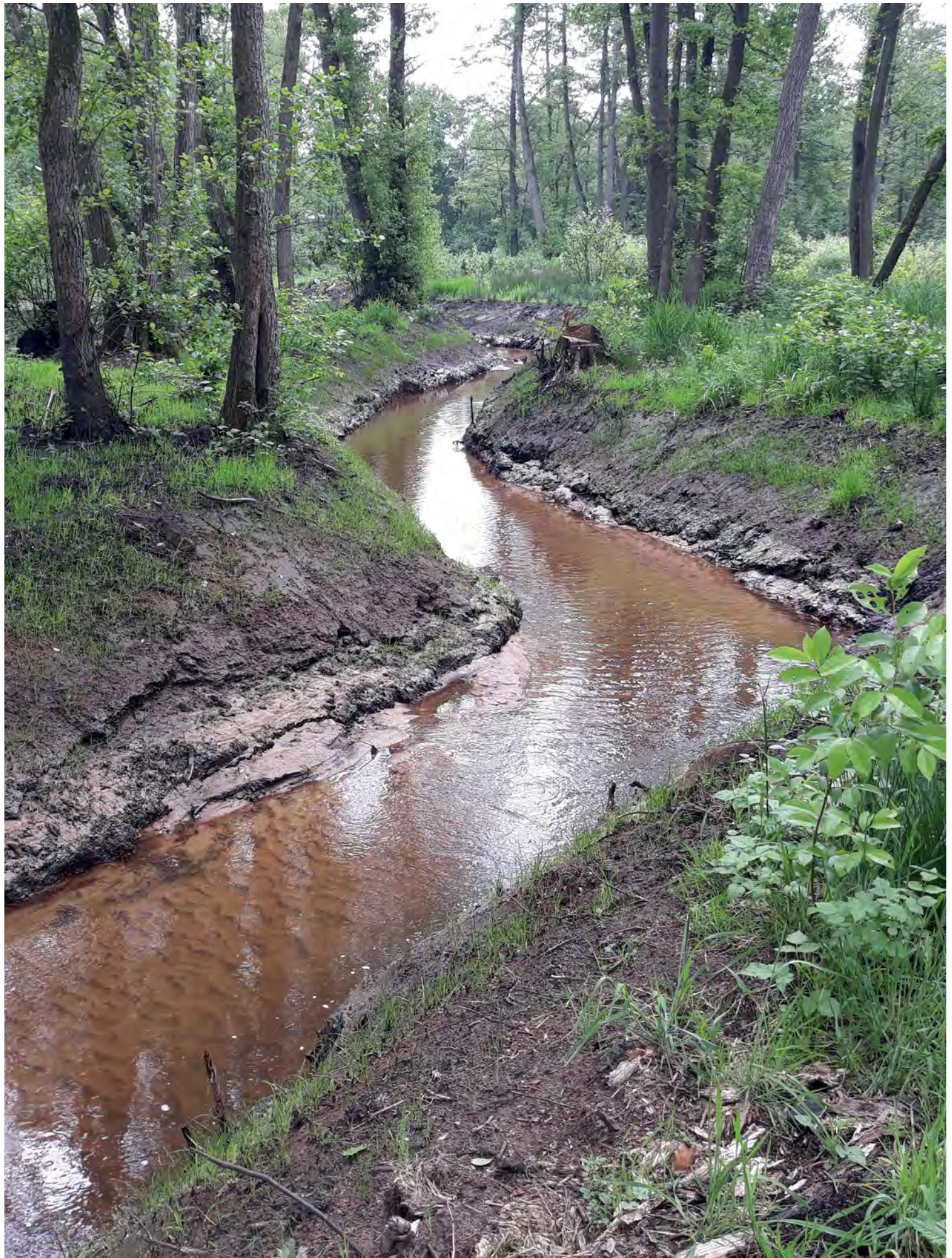
Uitgevoerde hermeandering Bolissenbeek (Foto: watering De Dommelvallei)
