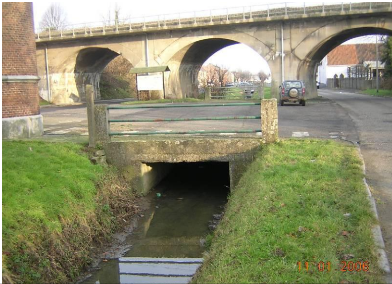
overwelving opw. spoorweg - Nerem
