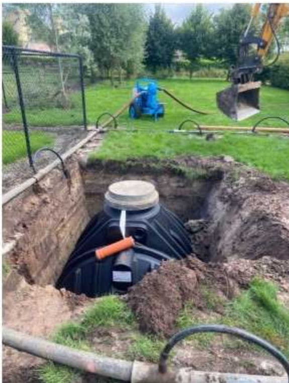
Individuele Behandelingsinstallatie voor Afvalwater (IBA). © Dorien Mahieu
