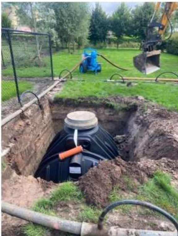
Individuele Behandelingsinstallatie voor Afvalwater (IBA). © Dorien Mahieu
