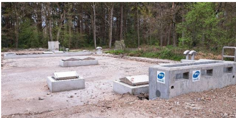
Aanleg van een bergbezinkingsbekken in de Slipstraat (Achel)
