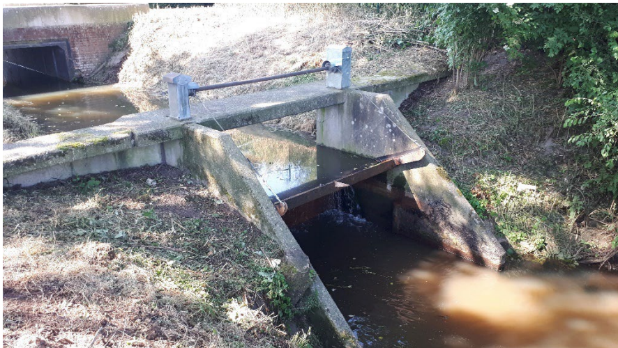
Herstelde stuw in functie van waterconservering op de Raamloop.
