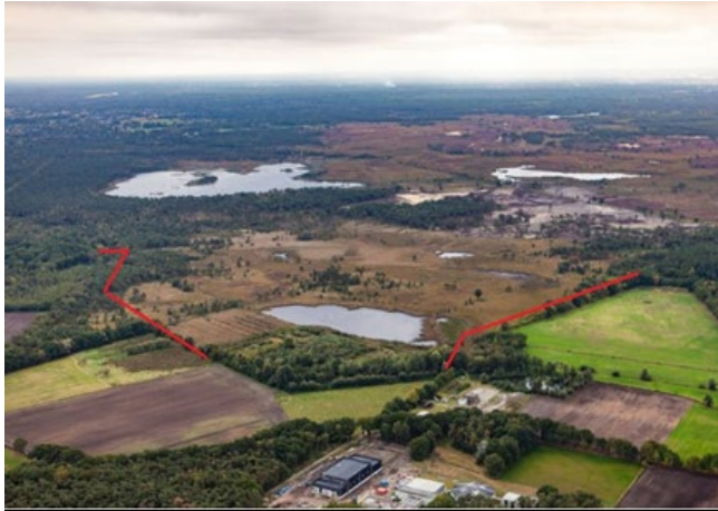
Het waterdichte scherm aan De Nol
