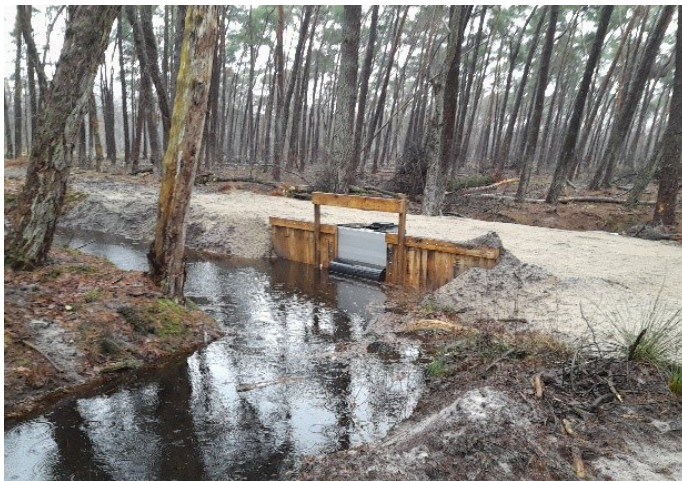
Één van de geplaatste stuwen in de Kalmthoutse heide
