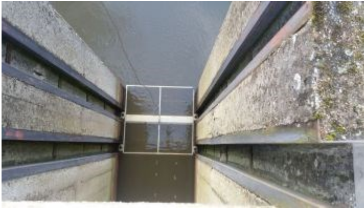
Figuur 19: Neergelaten constructie tussen de uitsparingen
