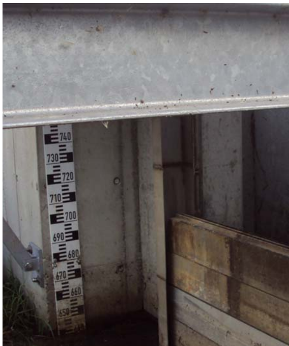
Overloop met schotbalken
