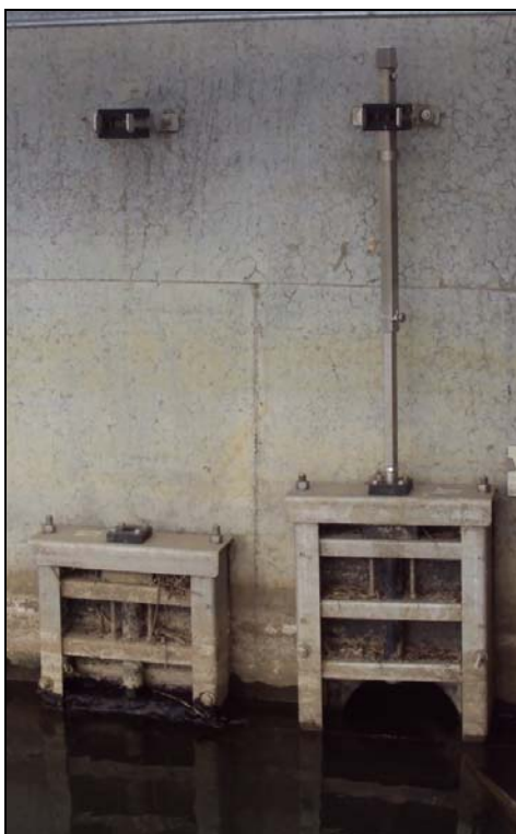
Figuur 1 : Foto van de twee openingen met schuifafsluiter in de Westerdijk.
