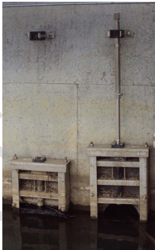
Doorvoeropeningen met schuifafsluiter
