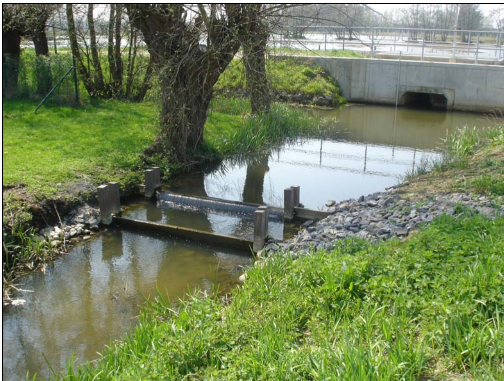
Figuur 4 : Foto van de gerealiseerde vistrap afwaarts van de Westerdijk.
