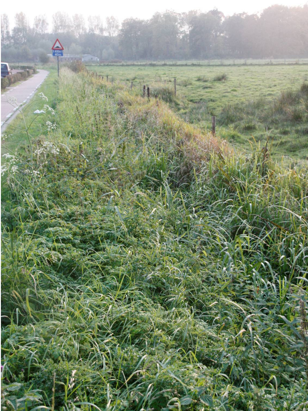
Figuur 7: Zicht op de baangracht langsheen Sint-Trudostraat welke instaat voor ontwatering van het gebied
