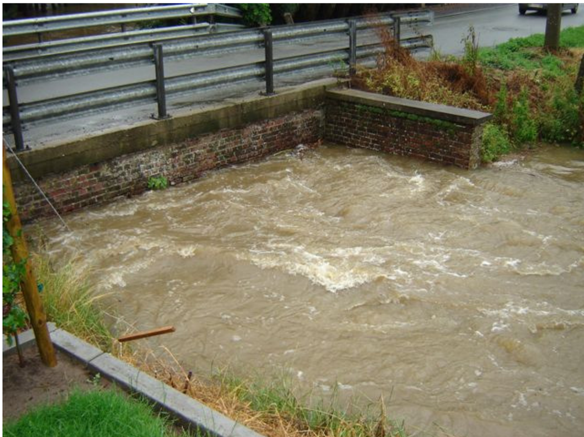
Figuur 28: Waterpeil Ringbeek t.h.v. brug Hoogweg – overstromingen juli 2005
