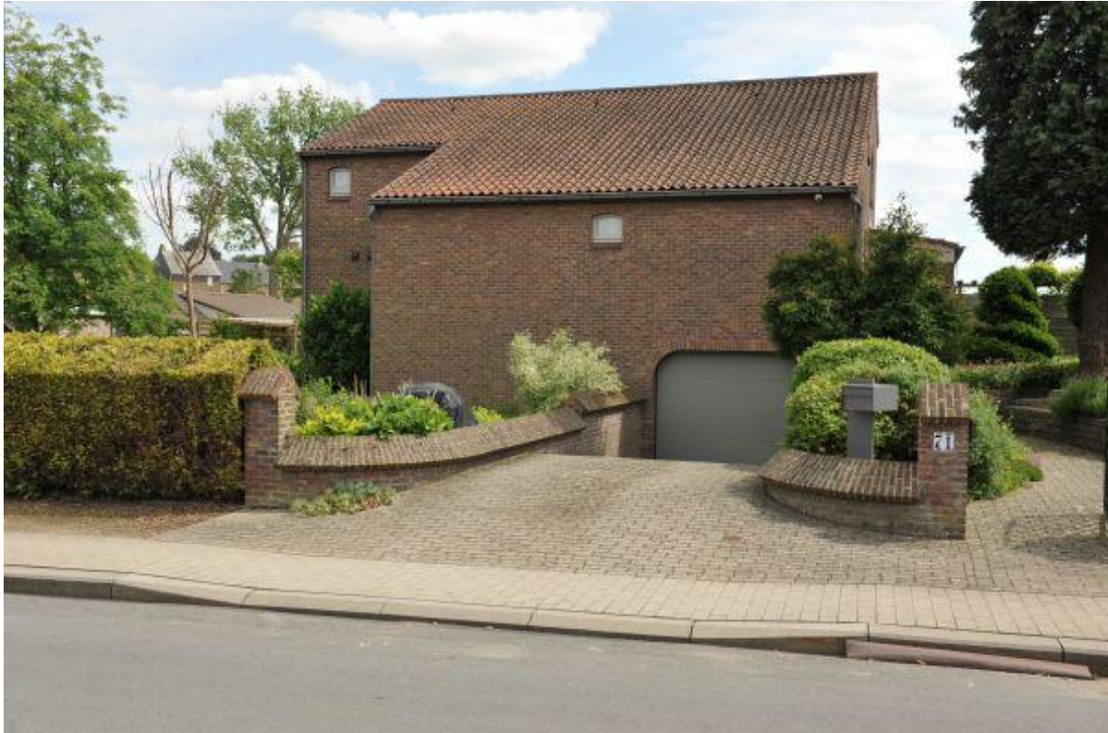
Figuur 23: verhoging voor inrit ondergrondse garage (Raatshovenstraat 71)
