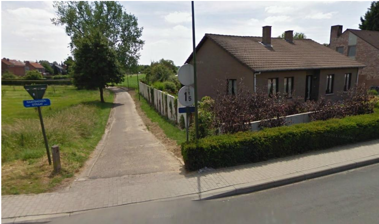
Figuur 21: beveiliging woning (Raatshovenstraat 67) via betonnen waterkeringsmuur (© Google Streetview)
