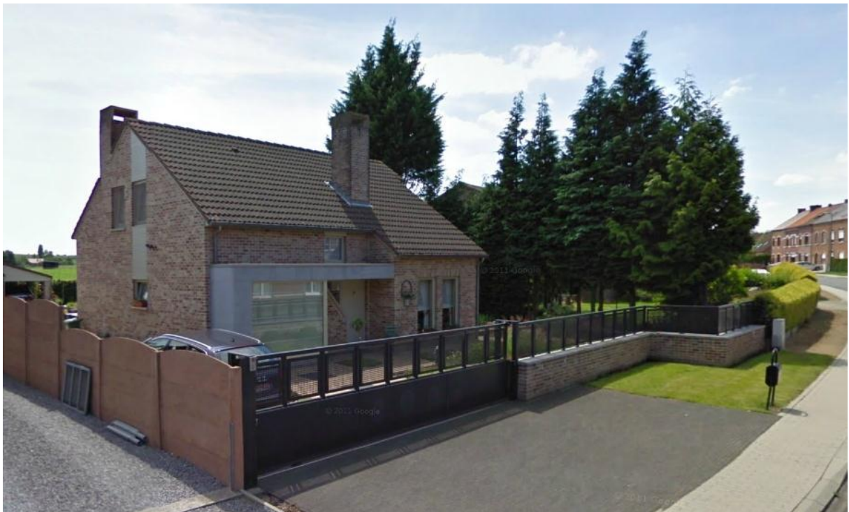
Figuur 22: verplaatsbare afsluitwand (Raatshovenstraat 69) (© Google Streetview)
