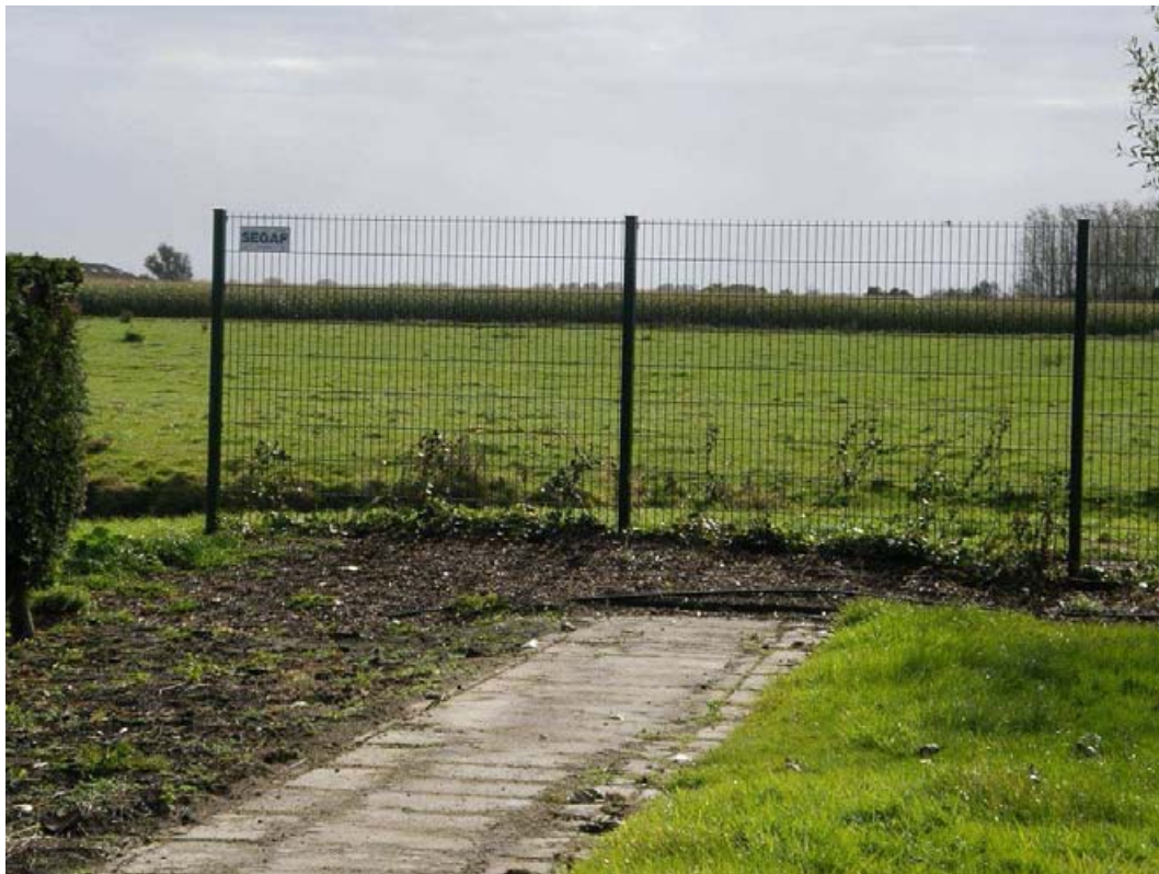
Foto 3: Terreinbezoek 18/10/11: zicht op weilanden met oplopend reliëf ten zuiden van de gemeentelijke begraafplaats.
