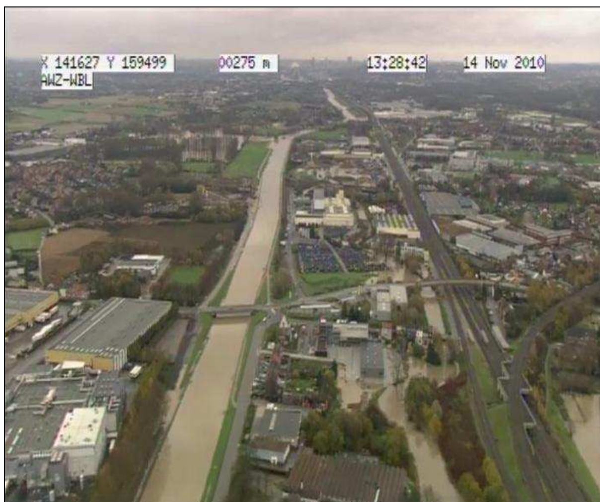
Figuur 129 Kritieke overstromingen langs de Vanhamstraat en de Pallieterweidestraat in Halle vanuit de Zenne
