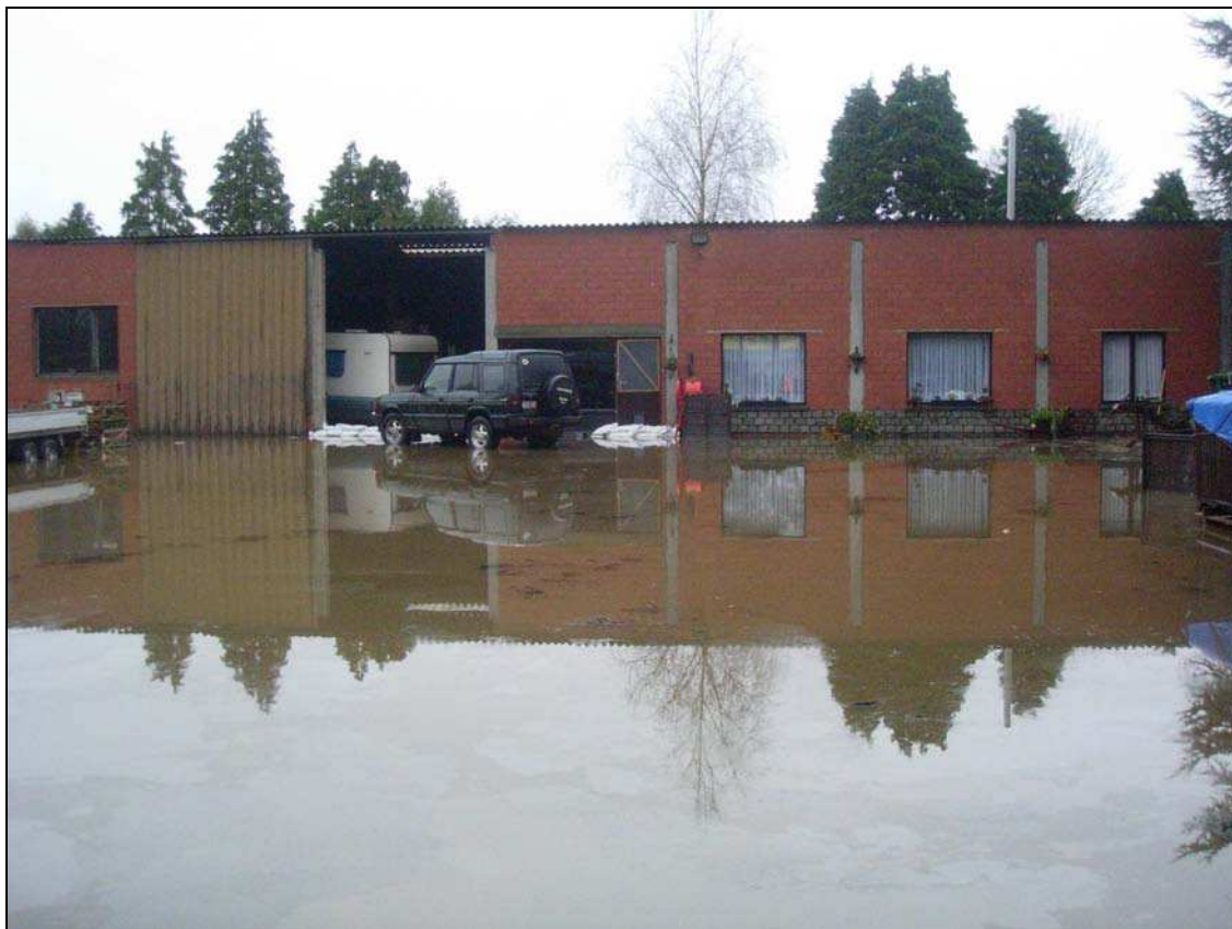
Figuur 297 Overstromingen Velddambeek (Rivierbeek) ter hoogte van een tegelbedrijf in Ruddervoorde
