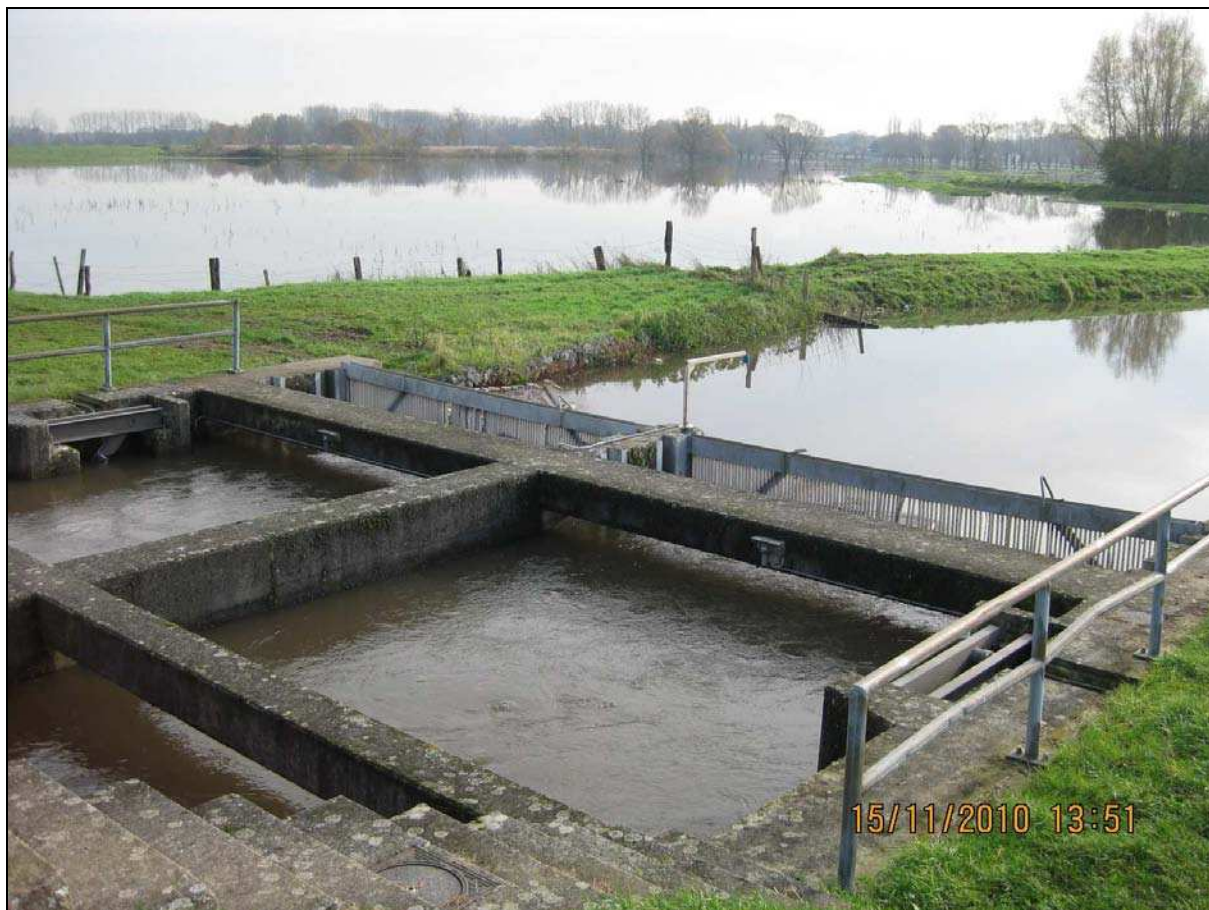
Figuur 158 Uitgebreide niet-kritieke overstromingen in het mondingsgebied aan het uitlaatkunstwerk van de Barebeek in Muizen
