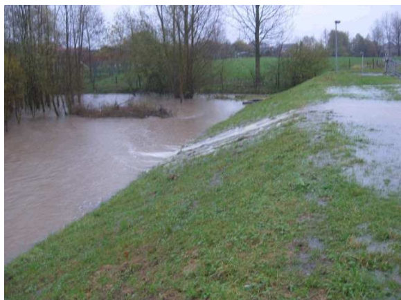
Figuur 207 Foto's ter hoogte van wachtbekken Schalmdries op het moment van overtopping. Links: Stroming over noodoverlaat. Rechts: Afwaarts het wachtbekken (bron: Agnes Bellemans)
