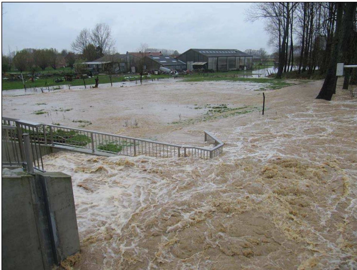
Figuur 99 Zicht afwaarts stuw 9 bis (OM436) langs de Marke in Sint-Pieters-Kapelle (13/11 15u): noodoverlaat in werking
