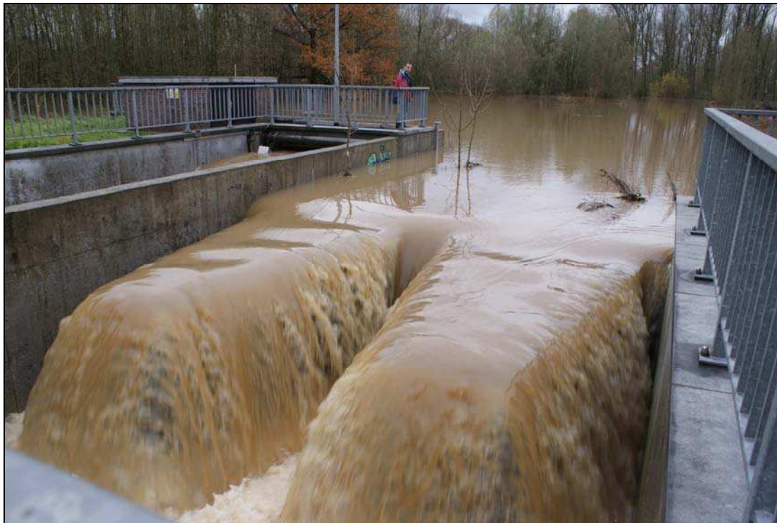
Figuur 67 Foto van de noodoverlaat aan stuw 6, GOG opwaarts de E40 in Erpe-Mere (14/11 14u54)
