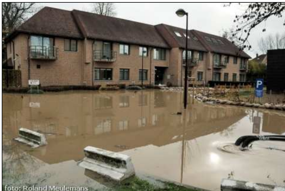
Figuur 138 Bijna-kritieke overstroming langs de Lotbeek t.h.v. 't Paviljoentje in de Fabriekstraat in Ruisbroek (bron: R. Meulemans)
