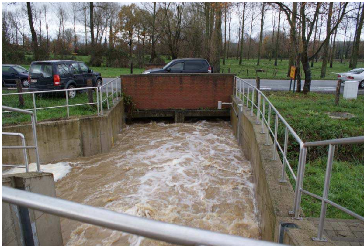
Figuur 70 Zicht vanop de stuw naar afwaarts het GOG Hollestraat (Molenbeek Erpe-Mere)(14/11 14u28). Op het moment van het hoogste waterpeil stond de duiker onder druk.
