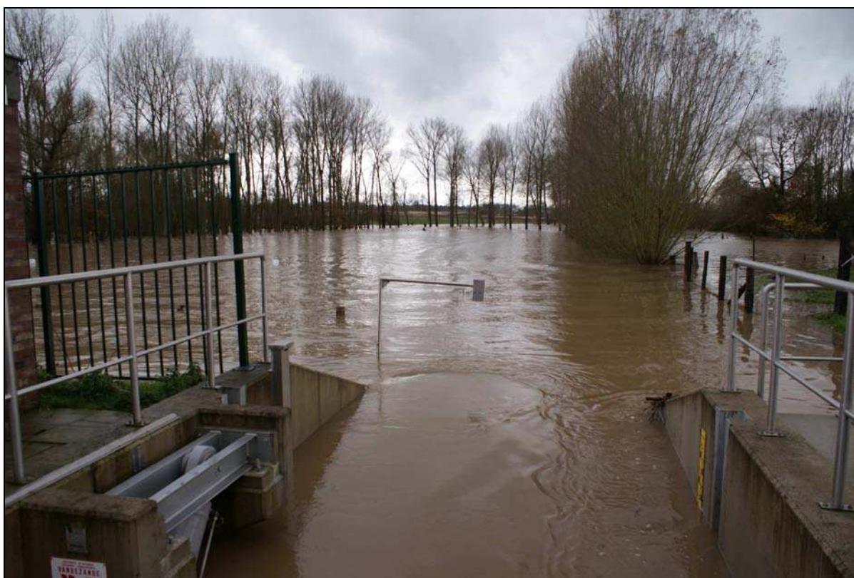
Figuur 71 Zicht vanop de stuw naar opwaarts het GOG Hollestraat (Molenbeek Erpe-Mere) (14/11 14u28 peil 34,10 m TAW)
