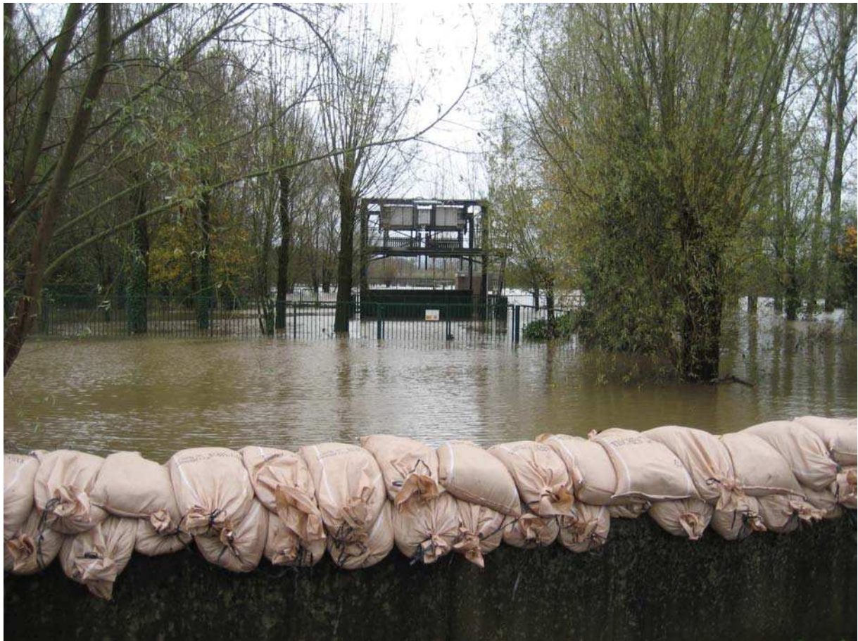
Figuur 202 Foto van het GOG Herdershoek op de Molenbeek Wetteren (14/11 om 7u30) met zicht op de roosterreinigers. De keermuur aan de Zuidlaan werd met zandzakken verhoogd.
