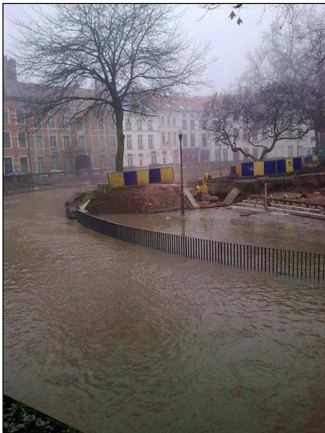
Figuur 120 Dijle in Leuven-centrum ter hoogte van de bouwwerf van de Dijleterrassen
