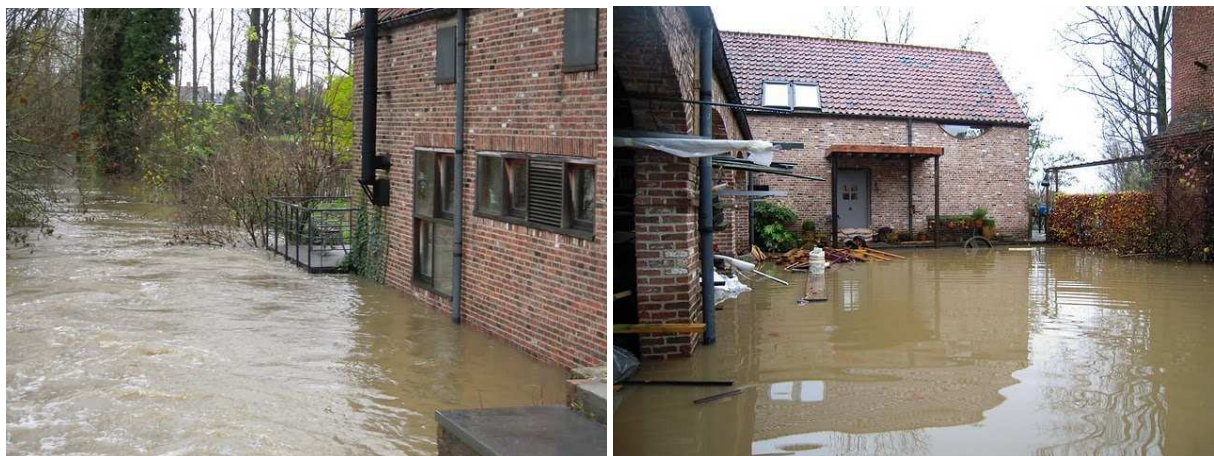
Figuur 204 Foto's van een woning op de Molenbeekweg die wateroverlast heeft gekend tijdens het hoogwater van november 2010 (14/11/2010). Op het maximum heeft het water 40 cm hoger gestaan. (bron: Aagje Van Damme)
