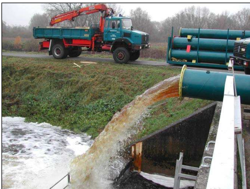
Figuur 274 Brandweer verpompt water aan de Bollaak in de Kleine Nete in Ranst
