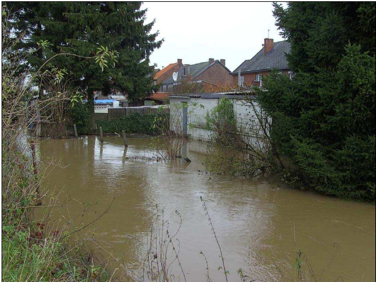
Figuur 234 Kritieke overstromingen in de Mosstraat (achterzijde) in Halen (stroomgebied van de Velpe)
