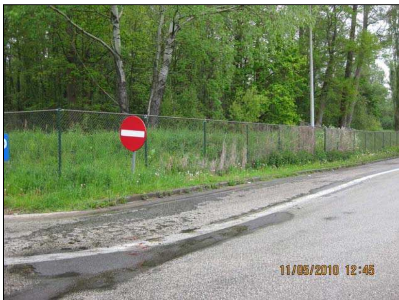
Figuur 118 Beschermingsdijk tussen het wachtbekken van Egenhoven en het tankstation langs de E40 voordat de bomen geroid werden
