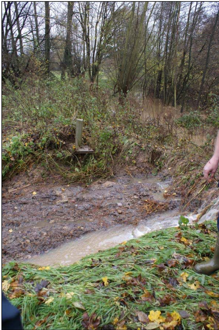
Figuur 80 Doorgebroken dijk aan het GOG op de Hunselbeek (14/11 rond de middag) (stroomgebied van de Bellebeek)
