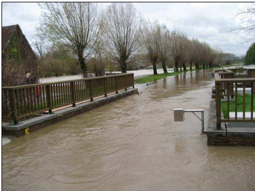
Figuur 40 Stuw 3 aan de Zwalmolen, verdronken in het water van de Zwalm (14/11 rond 18u)
