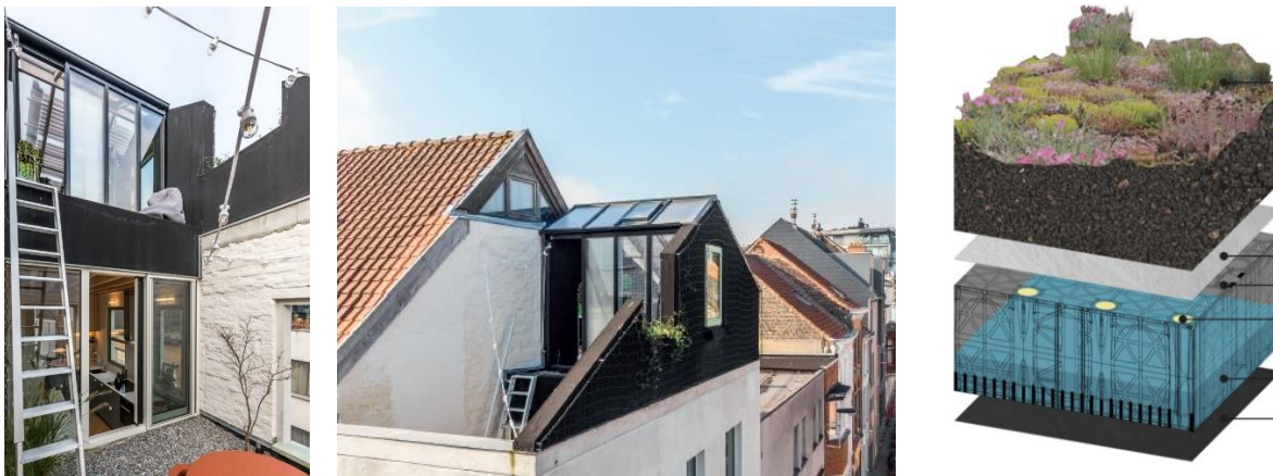
Figuur 10: project van Sutdio Haan - retentiedak van 3.000l
