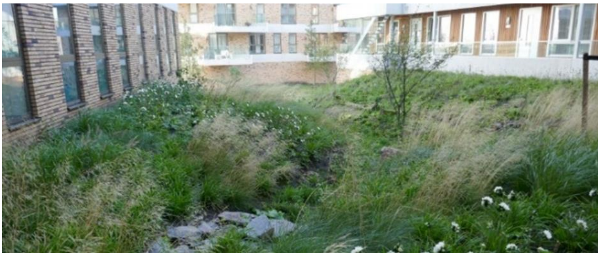
Figuur 19: Infiltratiebekken in IJburg van Hollandsgroen
