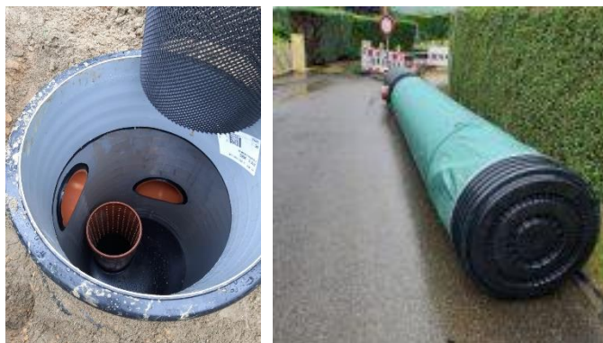
Figuur 14: Verticale infiltratiepalen
