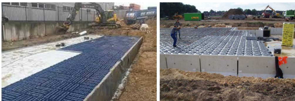
Figuur 17: Ondergrondse infiltratiebekkens
