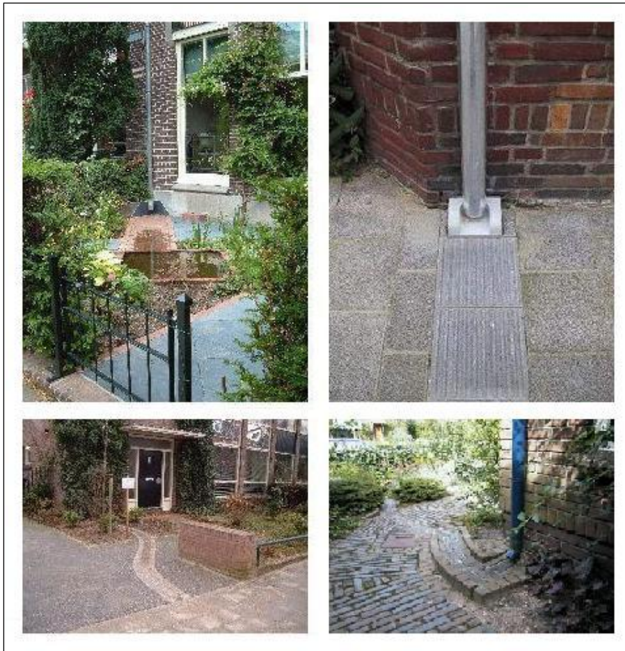
Figuur 1.3: Bovengrondse afvoergootjes
