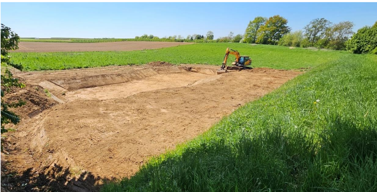
Foto 4: infiltratiezone in bestaande erosiebuffer (bron: Watering van Sint-Truiden)
