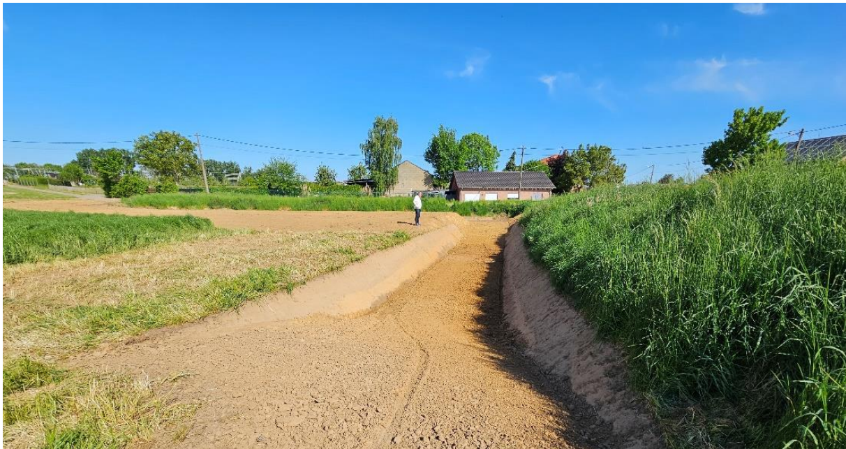
Foto 2: infiltratiezone in bestaande erosiebuffer na aanleg (bron: Watering van Sint-Truiden)
