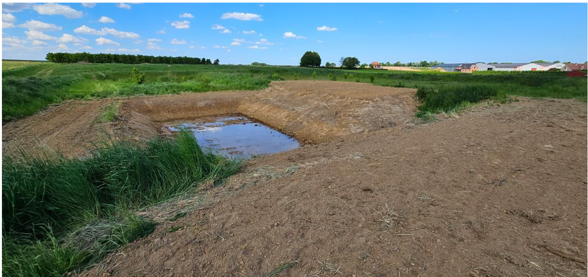
Foto 6: infiltratiezone in bestaande erosiebuffer (bron: Watering van Sint-Truiden)
