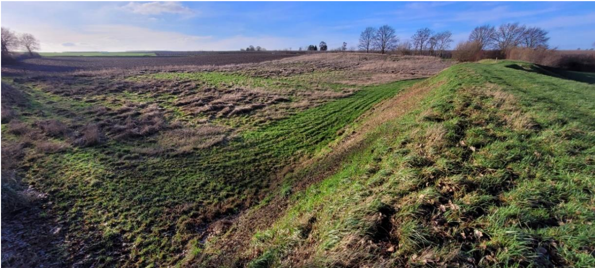
Foto 3: oorspronkelijke toestand erosiebuffer (bron: Watering van Sint-Truiden)
