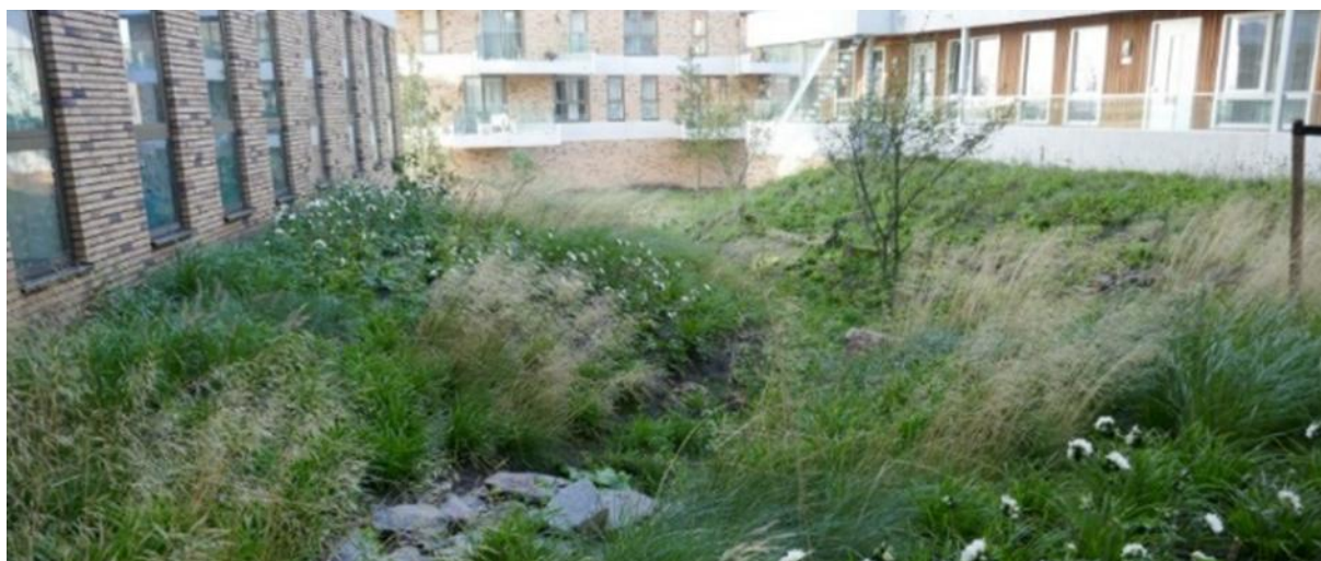
Figuur 21: Infiltratiebekken in IJburg (Hollandsgroen)
