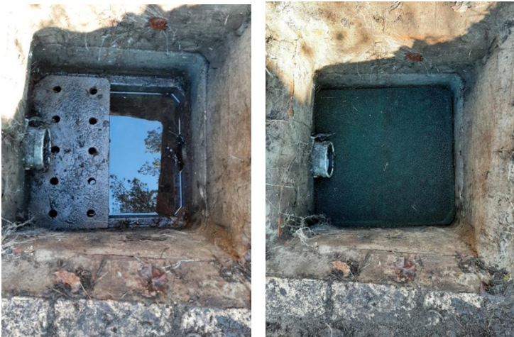
Figuur 9: aansluiting van een hemelwaterput met controleput en terugslagklep
