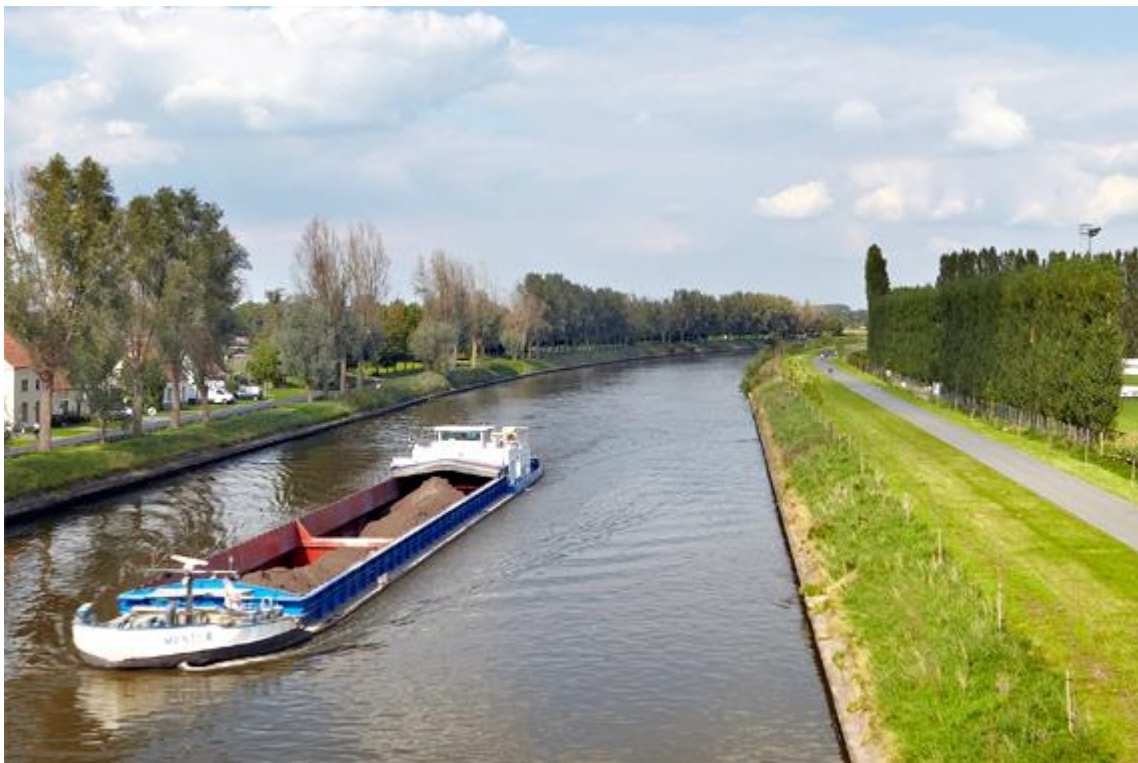
Afbeelding 9: Afleidingskanaal van de Leie ter hoogte van Nevele (Bron: http://www.seineschelde.be/nl/inhoud/overige-bochtverbredingen-nevele )
