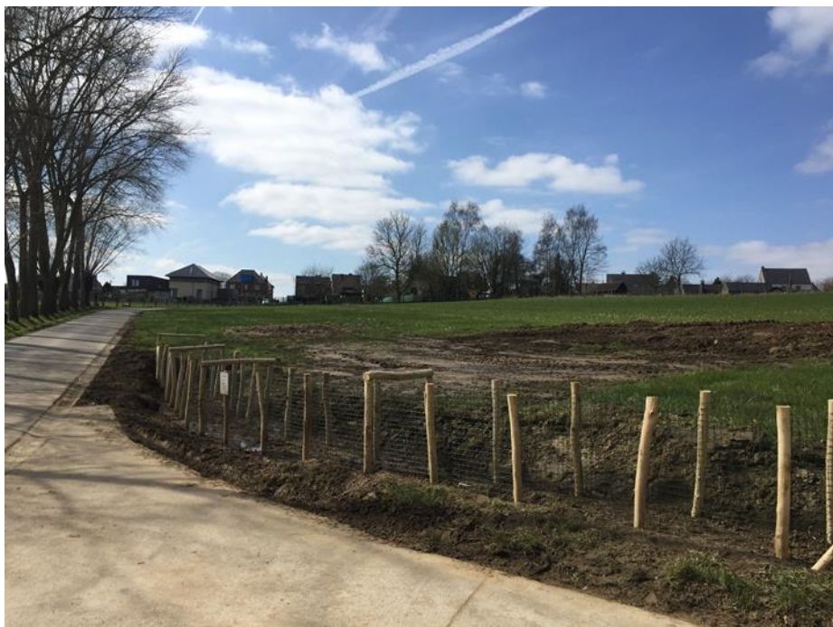
Foto: erosiedam te Zwalm (Kamperstraat)
