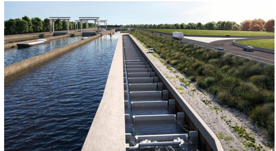
Op de grens tussen Gent en Merelbeke investeren we in rivierherstel door het bouwen van een vispassage naast het stuwsuiscomplex. (Bron: De Vlaamse Waterweg)
