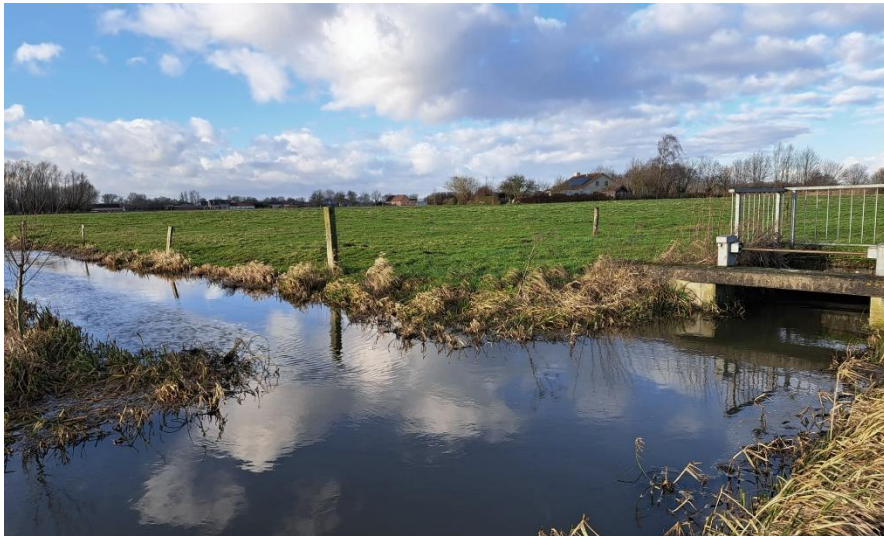
De stuw op de Borisgracht tussen de Merebeek en Oude Kale vormt een belangrijk kunstwerk voor het peilbeheer van de Merebeek en Oude Kale (Bron: VMM)
