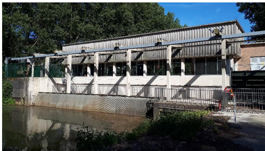
Pompgemaal Stenengoot te Verrebroek
