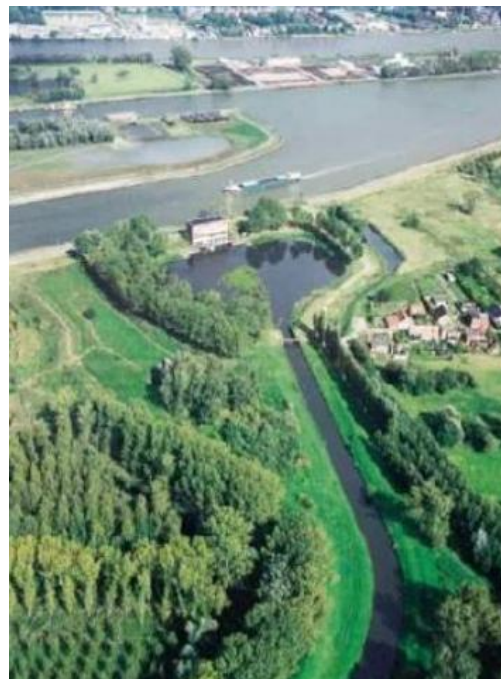
Wachtboezem met pompgemaal in de huidige situatie
