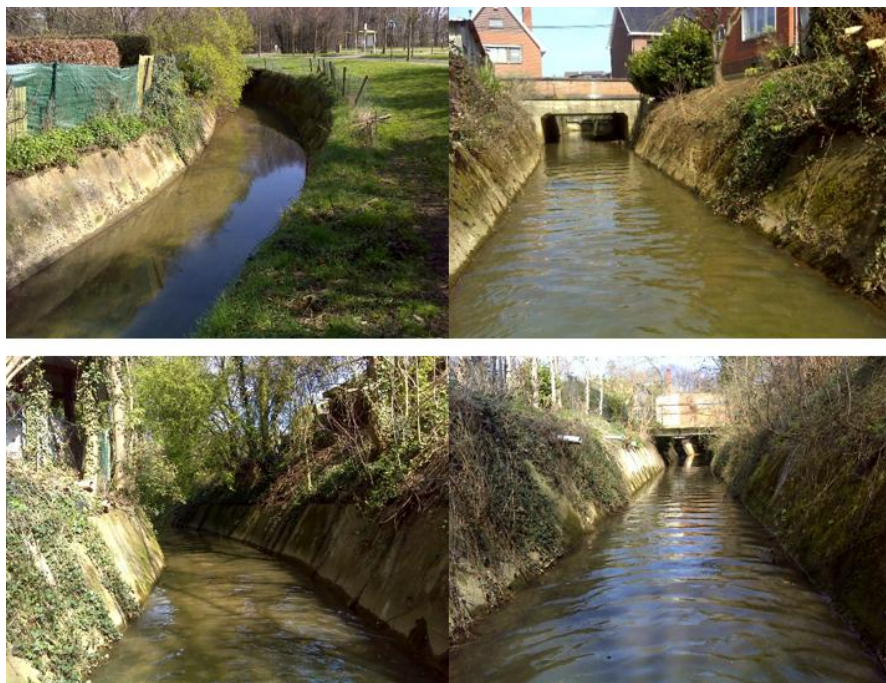
Algemeen beeld van de gebetonneerde bedding van de Begijnbeek tussen de Tulpenstraat en de Omer Vanaudenhovenlaan
