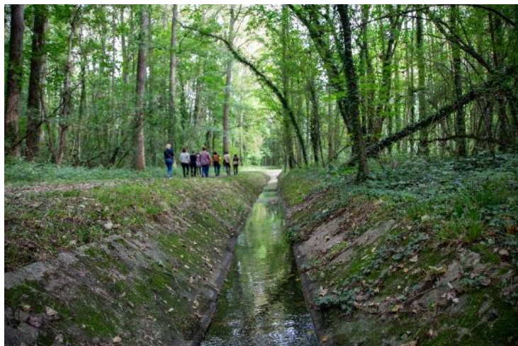
Rechtgetrokken en verstevigde Kautesteenbeek (© VMM)
