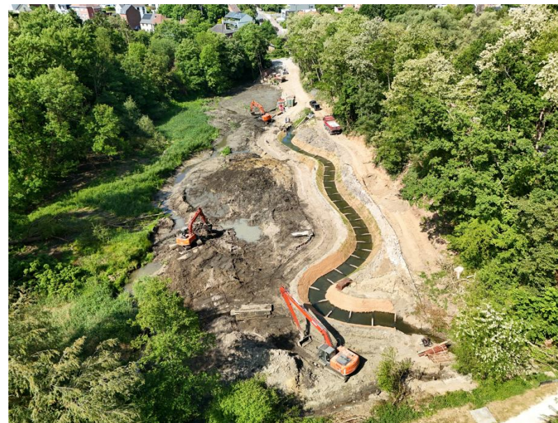
Luchtbeeld van de werken aan de Gevaertvijver (© Tom De Bie)
