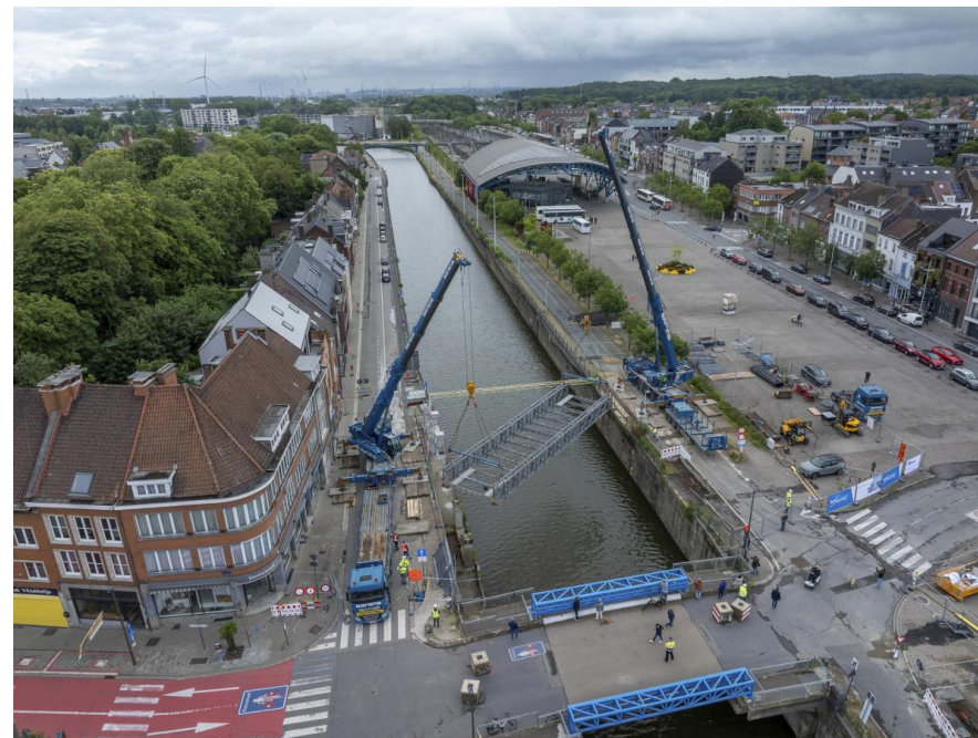
Verplaatsing van de Baileybrug in Halle (© De Vlaamse Waterweg)
