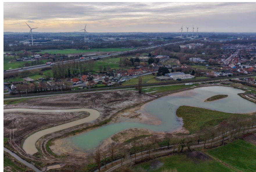
Figuur 13: De werken aan het bufferbekken
