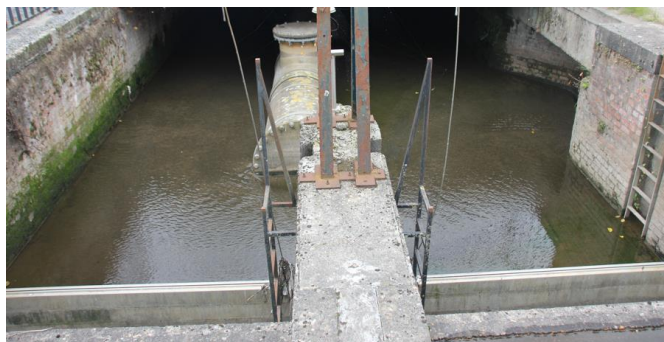
Figuur 42 De Collevijverbeek (links) mondt uit in de Mandel (rechts) en loopt ingekokerd verder (rechts). Bij hoge waterstanden stort het water over, samen met de noodoverlaat van de Grote Bassin naar het Kanaal Roeselare-Leie (onder)
