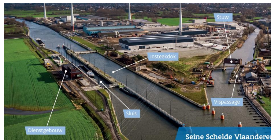
Figuur 33 Nieuwe sluis in Sint-Baafs-Vijve, met vispassage en insteeddok
