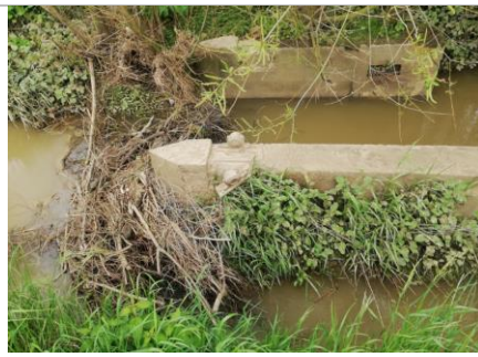
Figuur 10: Stuw 3: afwaarts spoorweg, Gaaistraat, Deerlijk
