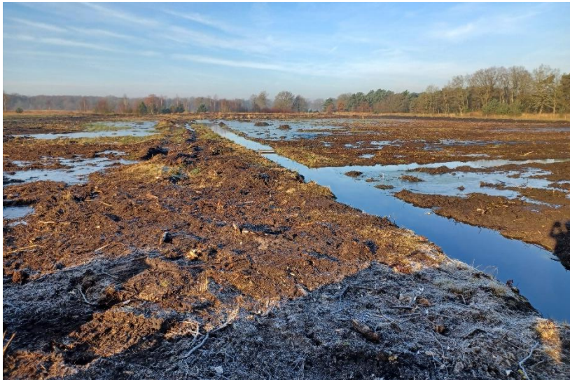
Overzicht van de ingrepen binnen het BLUE DEAL project van ANB aan de Achelse Kluis (boven) en foto van de werken (onder) (bron: ANB)
