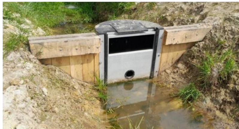
Nieuw geplaatste perceelssluw (foto provincie Antwerpen)
