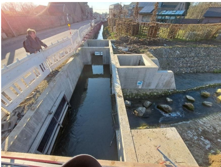
In het midden de molenarm naar 't Moleke op de Voer, links de afsluitbare schuif voor de hoogwaterbypass en rechts het begin van de bypass rond de molen met een passeerbare helling voor vissen.
