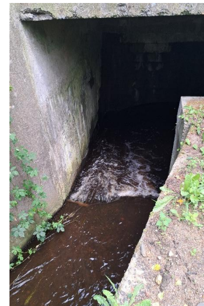
Het verval door de molenstuw aan de Dorpermolen (links) wordt vanaf 2025 omzeild door de VMM. Het bodemverval aan de duiker onder de Zuid-Willemsvaart (rechts) werd in 2024 opgelost door de provincie Limburg.
