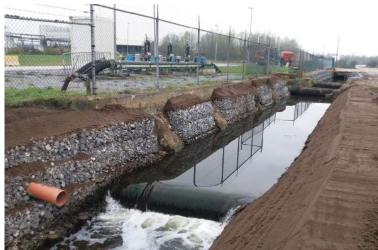
Oude kokers hinderen een vlotte doorstroom op de Eindergatloop; Deze zullen verwijderd worden (foto: provincie Limburg)
