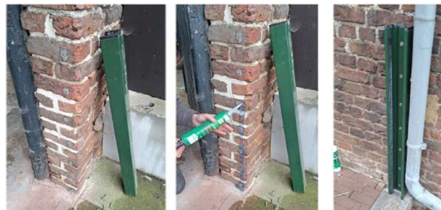
Plaatsen van geleiders voor schotten (bron: VMM)
