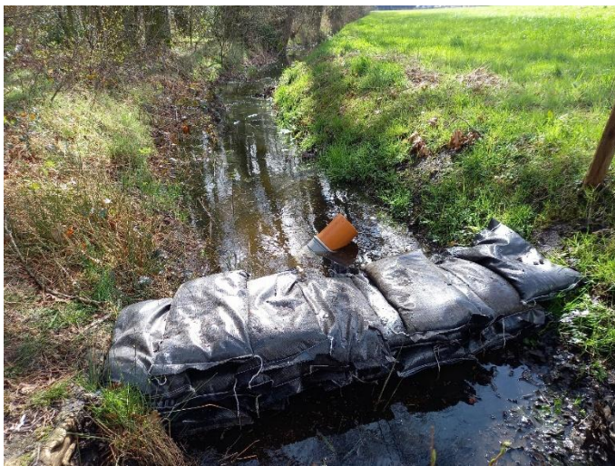
Drempel met zandzakjes in Gortenloop (foto: watering De Dommelvallei)
