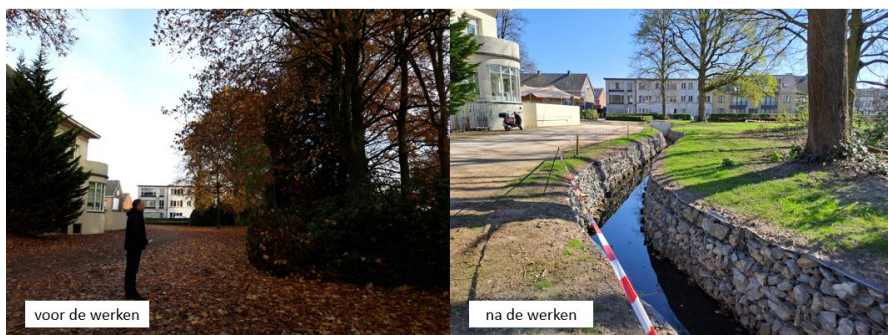
Foto's: Fase 1 (Aanleg open bedding t.h.v. Turnhoutsebaan) (©Provincie Antwerpen)
