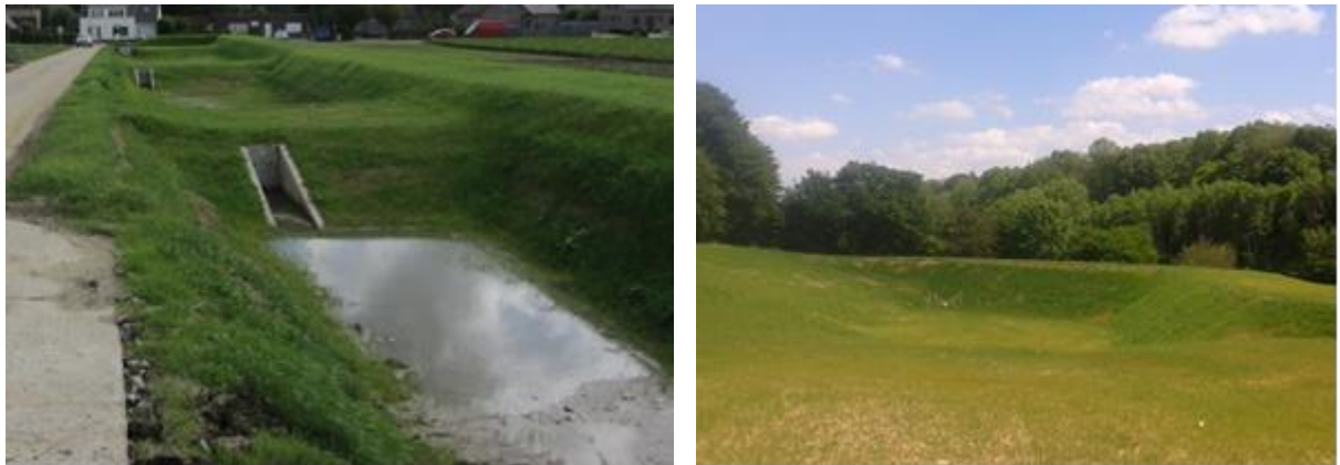
Figuur 22: links: bufferconstructie langs de Romeinse Kassei in Koninksem; rechts: erosiedam Voeren
