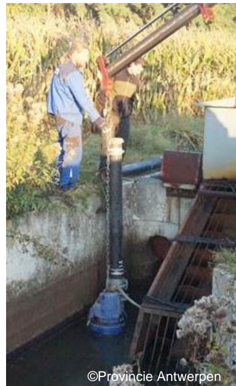
Figuur 14: Pompllocatie op de Meerloop die vernieuwd wordt en plaatsing van tijdelijke pomp (rechts)
