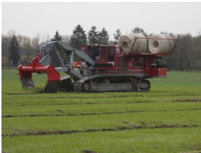
Figuur 6: Sleufloze aanleg van drainagebuizen voor peilgestuurde drainage te Neerpelt
